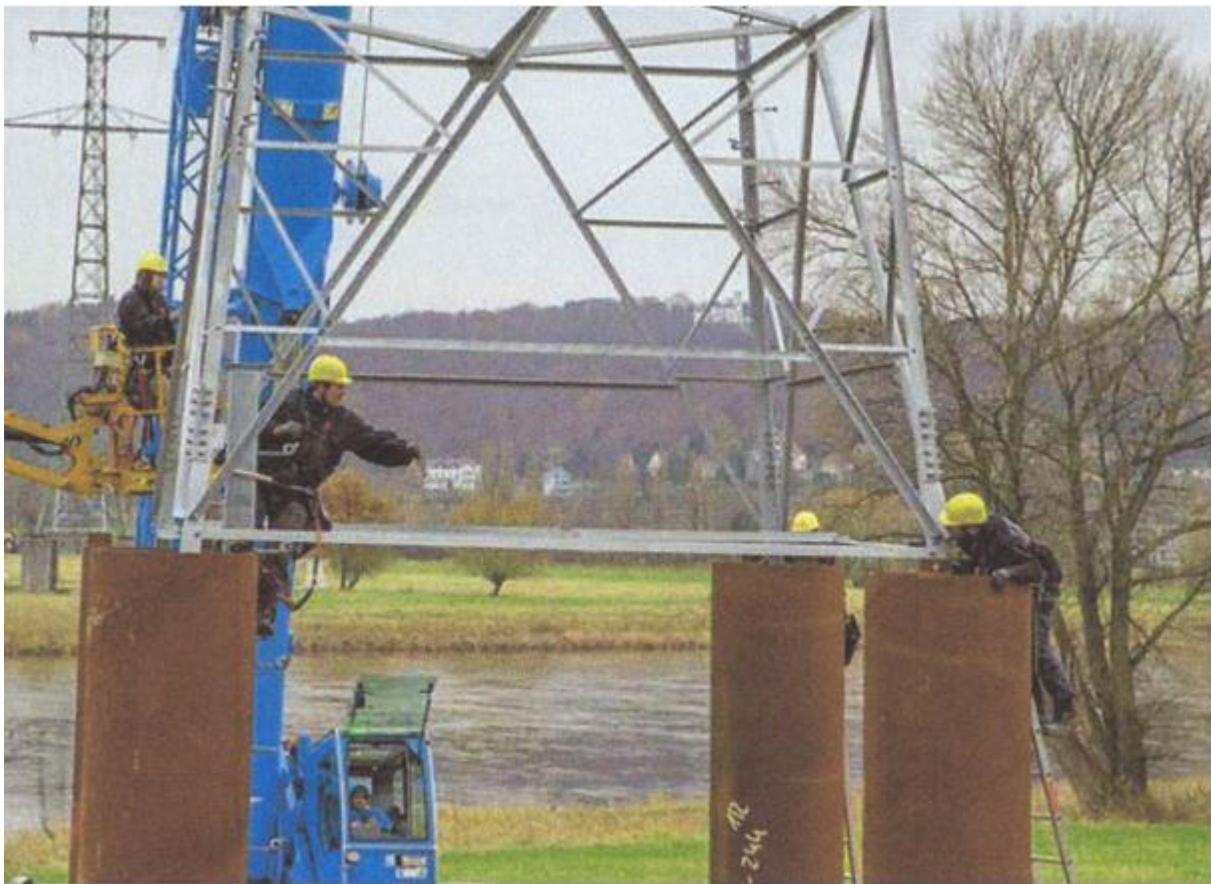
Abbildung 5: Foto von der Herstellung eines Hochwasserfundamentes
