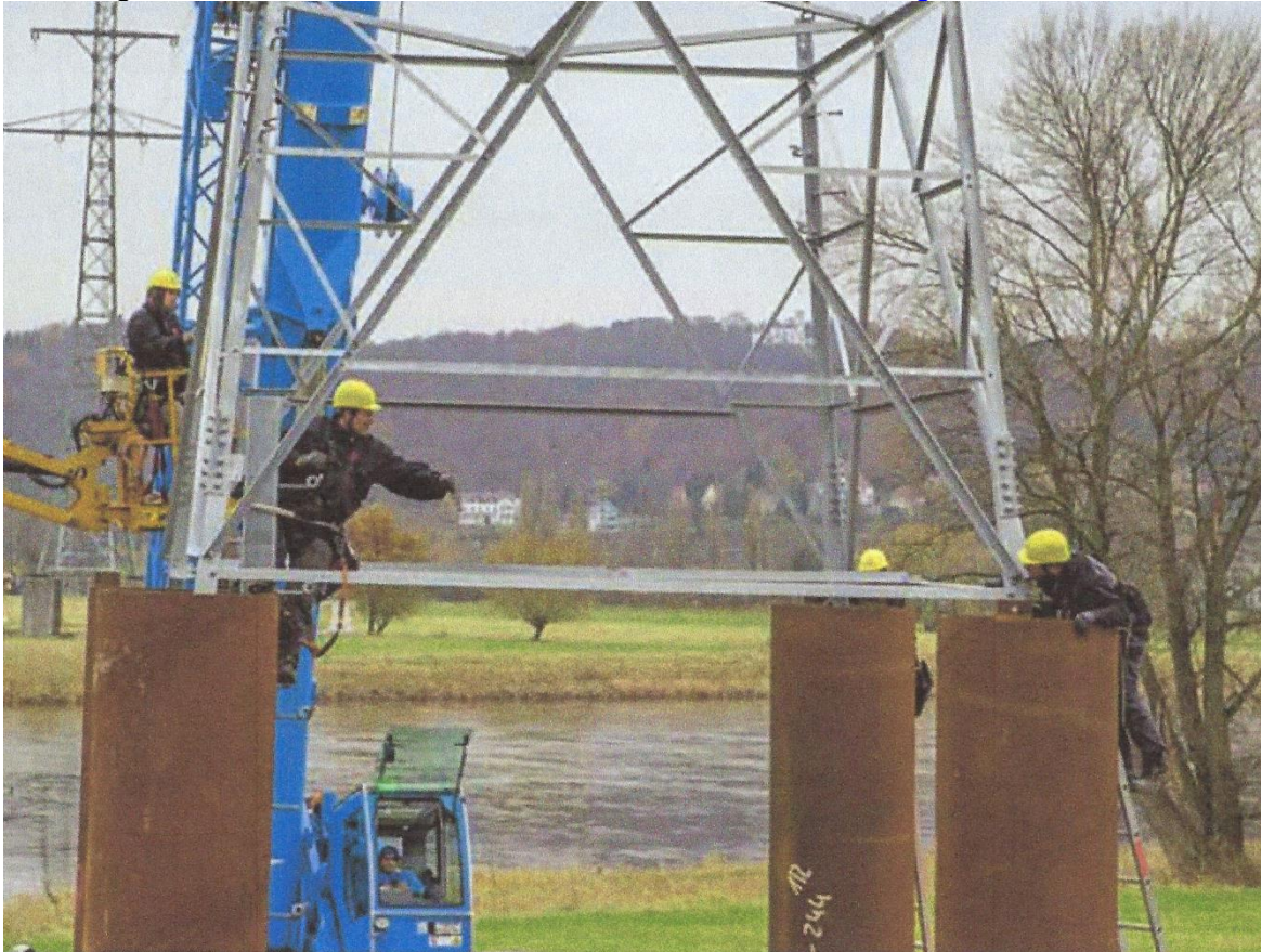
Abbildung 11: Herstellung eines Hochwasserfundaments
