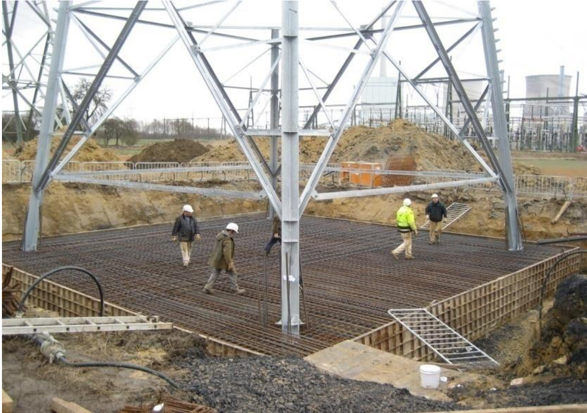
Abbildung 17: Montage der Fundamentbewehrung
