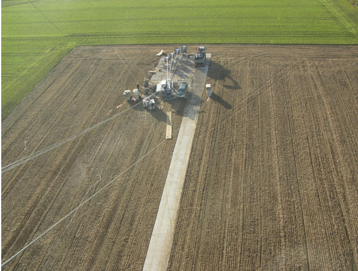
Abbildung 22: Windenplatz eines 4er-Bündel-Seilzuges
