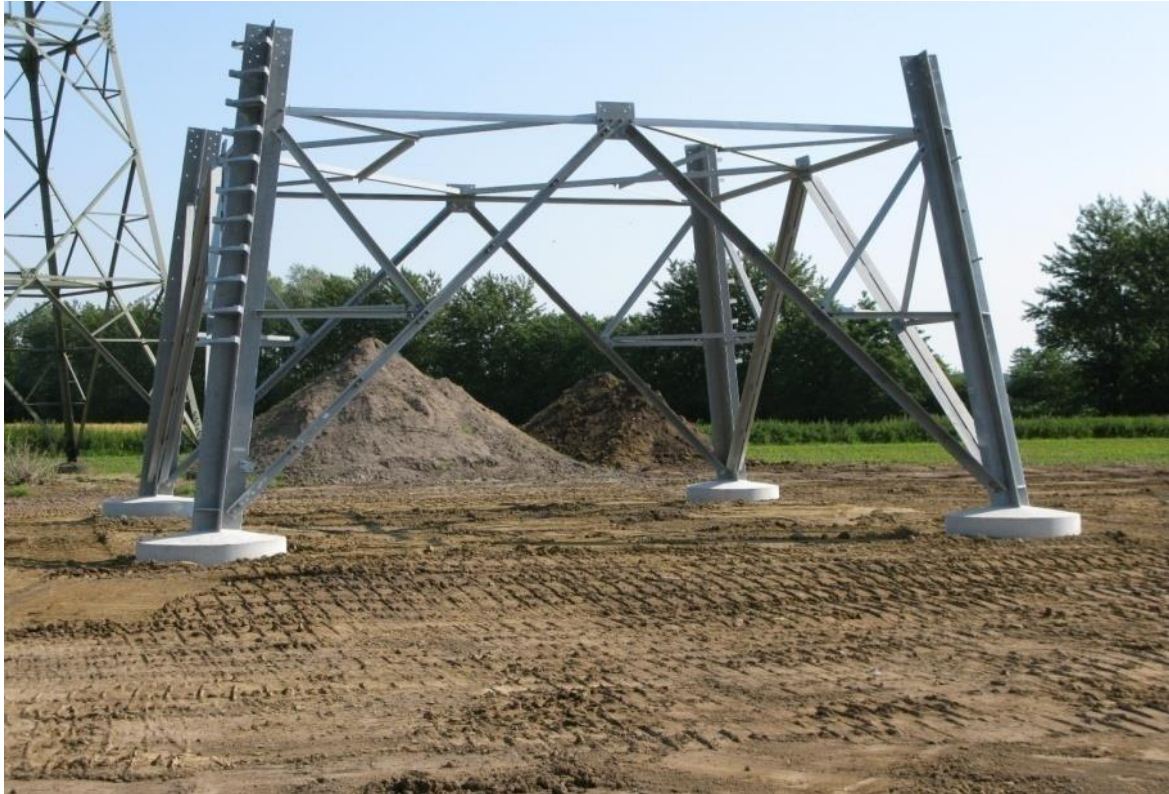
Abbildung 18: Montierter Mastfuß
