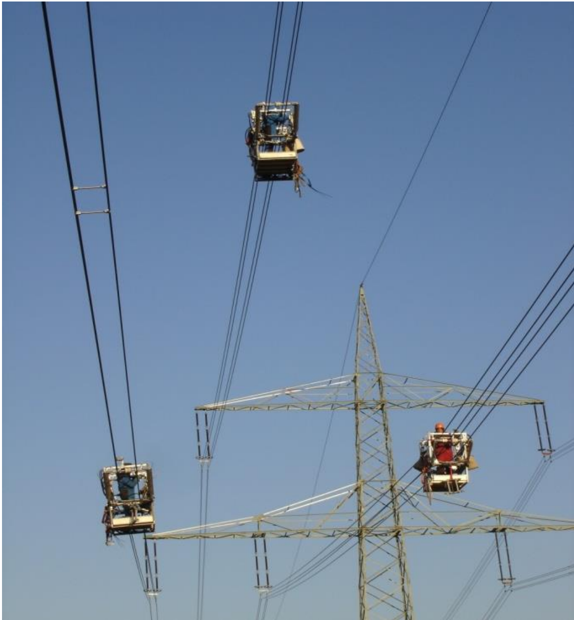
Abbildung 23: Montage der Feldbündelabstandhalter mit Fahrwagen
