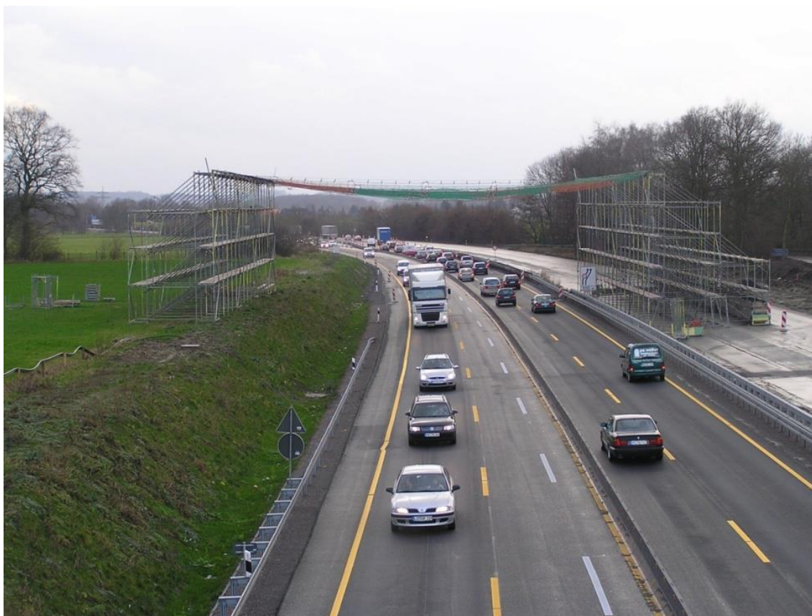
Abbildung 21: Stahlrohrschutzkonstruktion mit Netz über einer Autobahn
