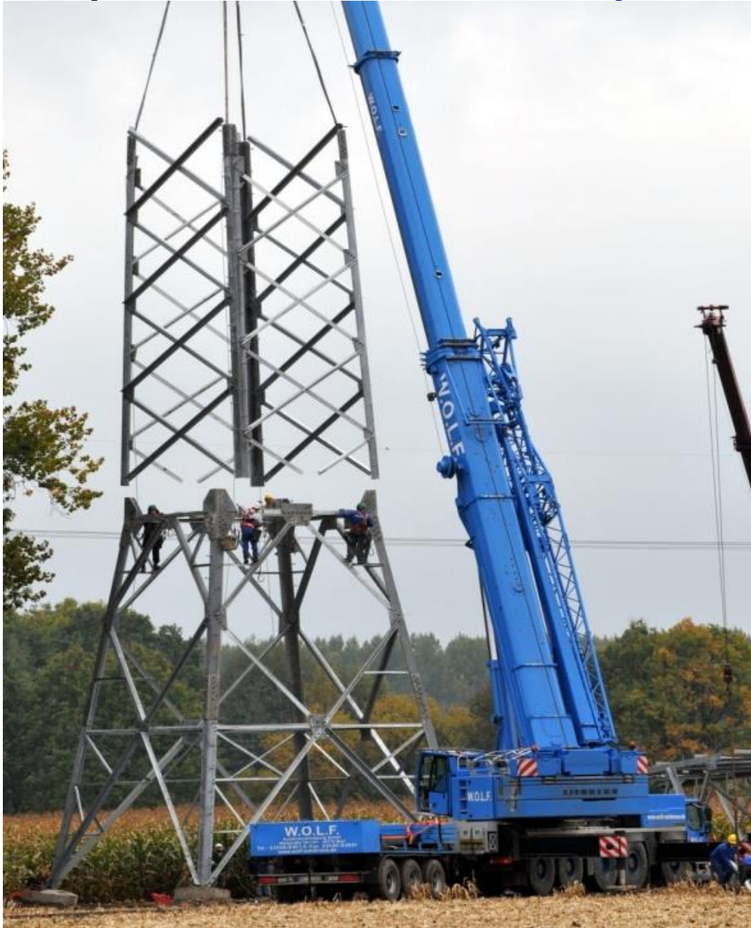
Abbildung 19: Mastmontage (Stocken)
