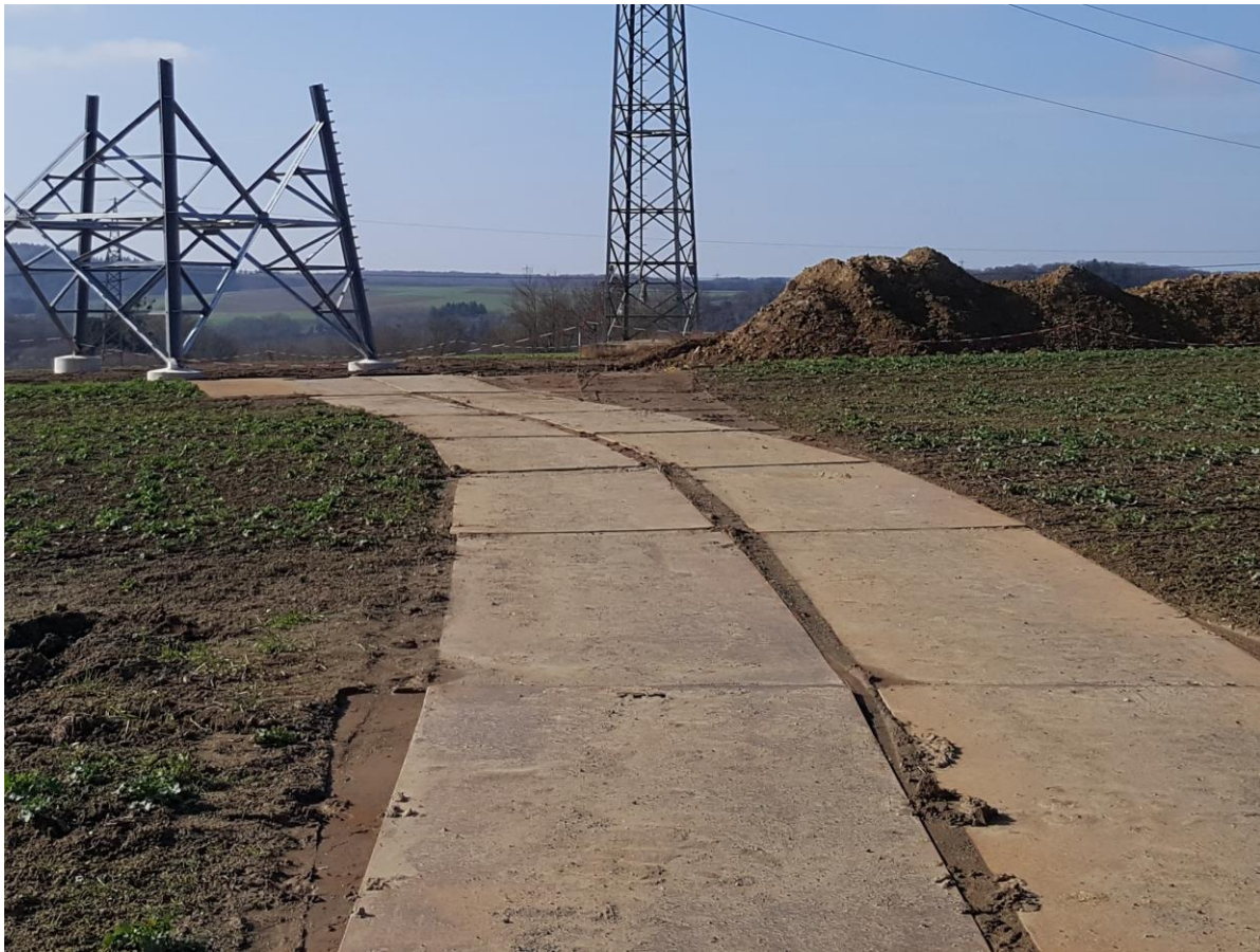
Abbildung 12: Temporäre Zuwegung über Fahrplatten
