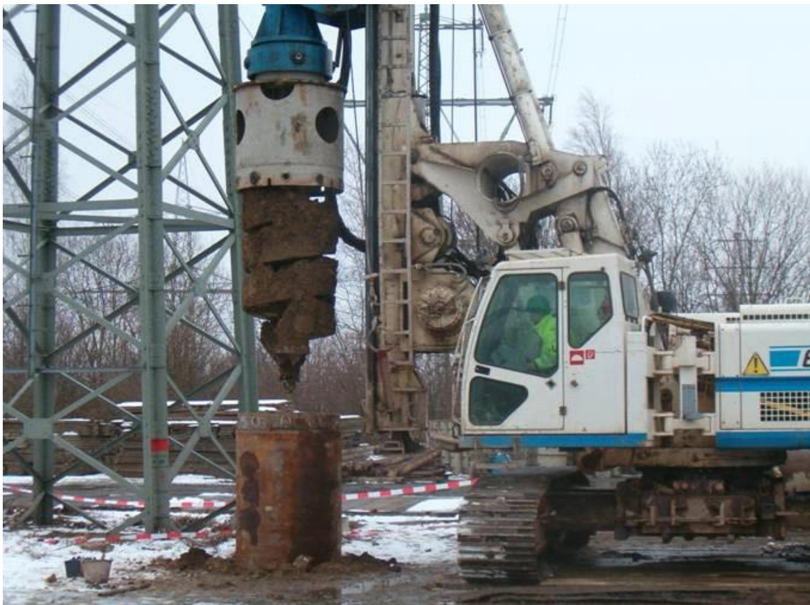
Abbildung 16: Bohrung für einen Bohrpfahl
