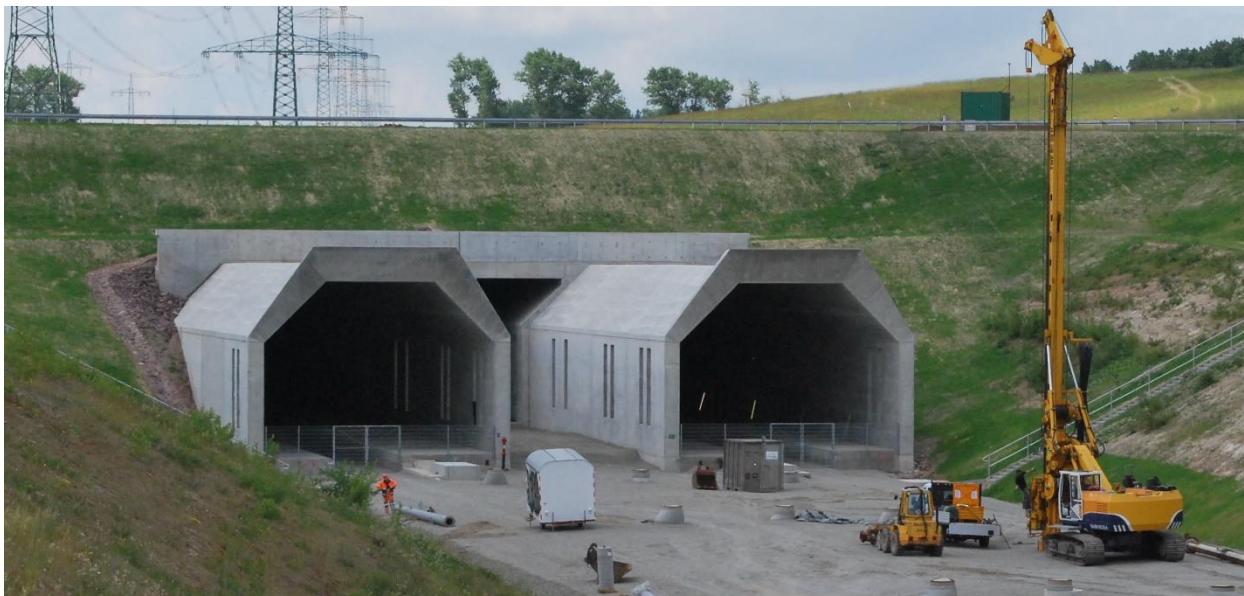
Abb. 19: Portalhaube am Bibratunnel (VDE 8.2) (Bild DB AG)
