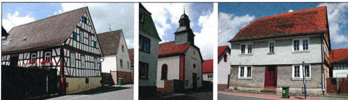
Abb. 9: Denkmalgeschützte Häuser (links, rechts) und Kirche (Wembach)
