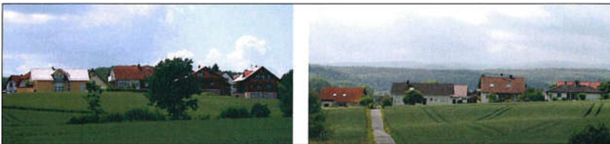
Abb. 13: Ortsränder von Hahn (links: östlicher Ortsrand; rechts: nördlicher Ortsrand)
