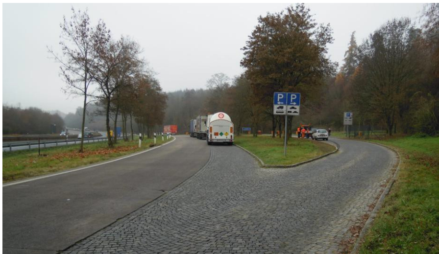
Abbildung 8 Derzeitiger Ausbauzustand Parkplatz Gaulskopf
