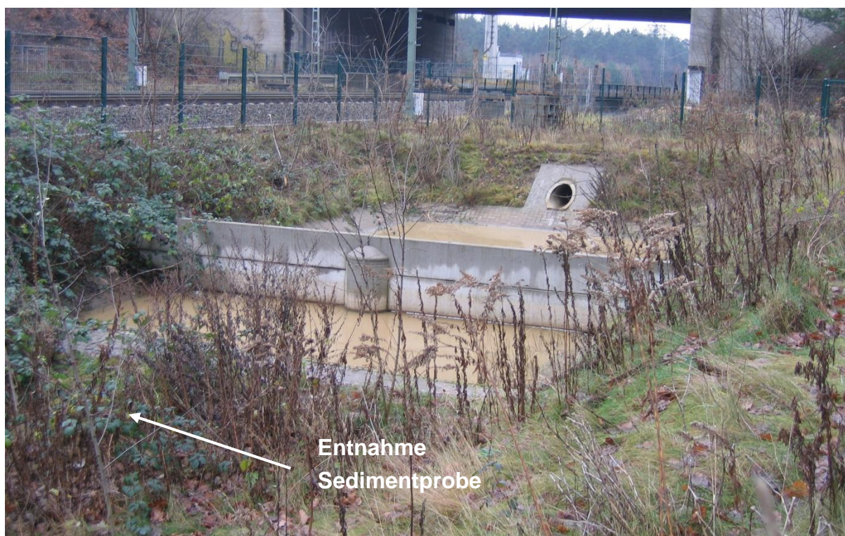
Abbildung 6 Absetz- und Versickerbecken Sportfeld
