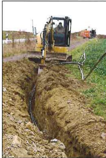
Abbildung 3: offene Bauweise mit Kleinbagger (Foto: gutschker-dongus)
