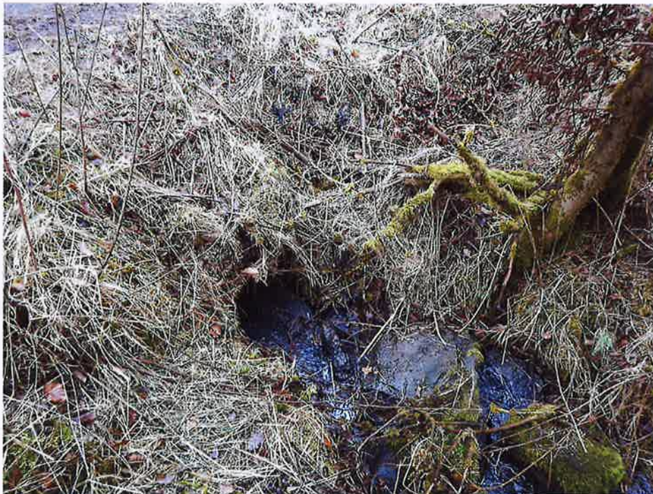
Durchlass und Wirtschafts-/Waldweg von Unterwasser
