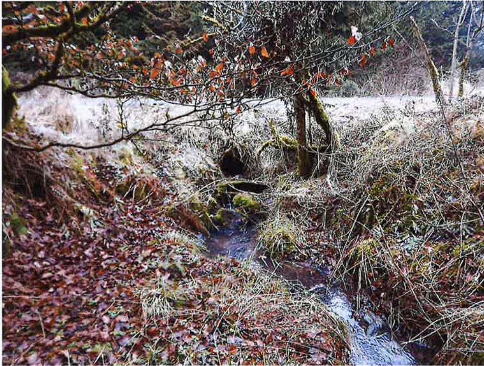
Durchlass und Wirtschafts-/Waldweg von Unterwasser
