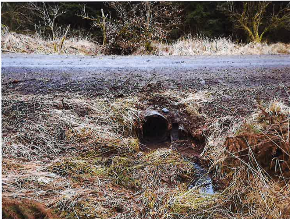
Durchlass und Wirtschafts-/Waldweg von Oberwasser
