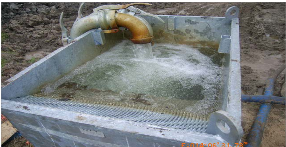
Abbildung 3: Beispiel eines Klär- und Absetzbeckens
