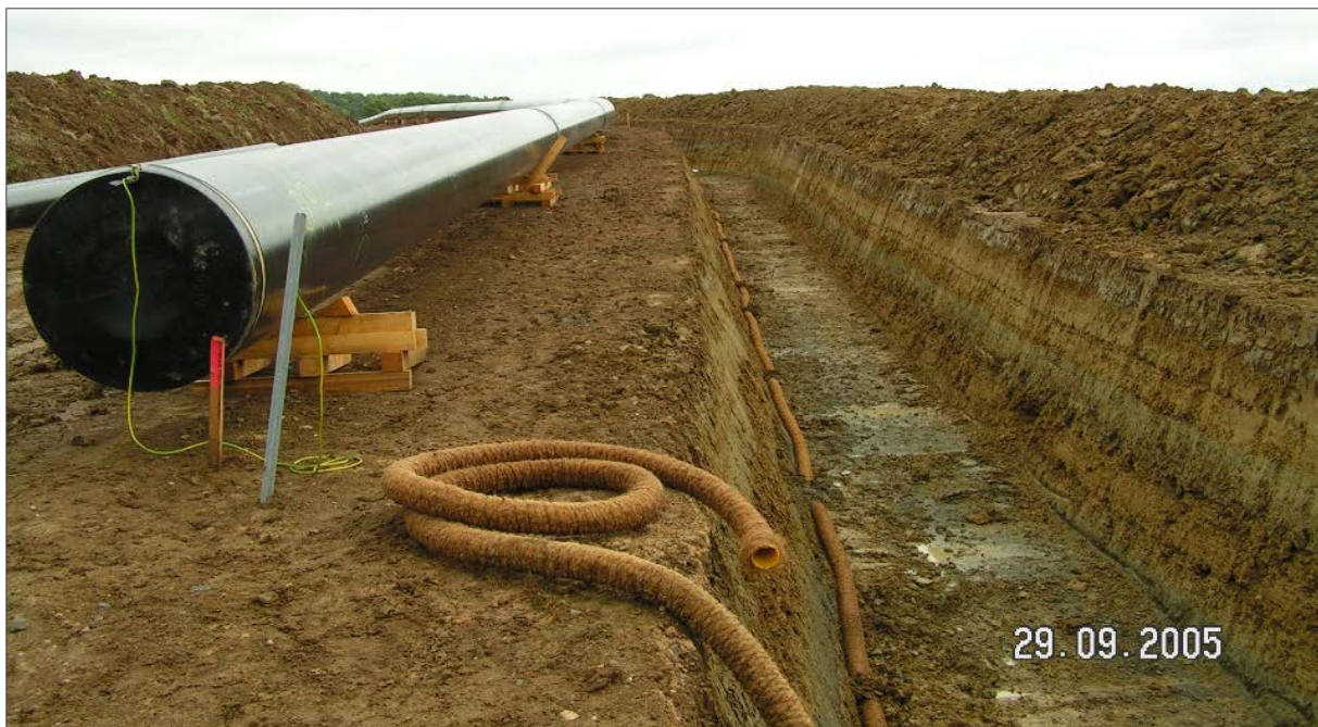
Abbildung 6: Beispiel offener Rohrgraben
