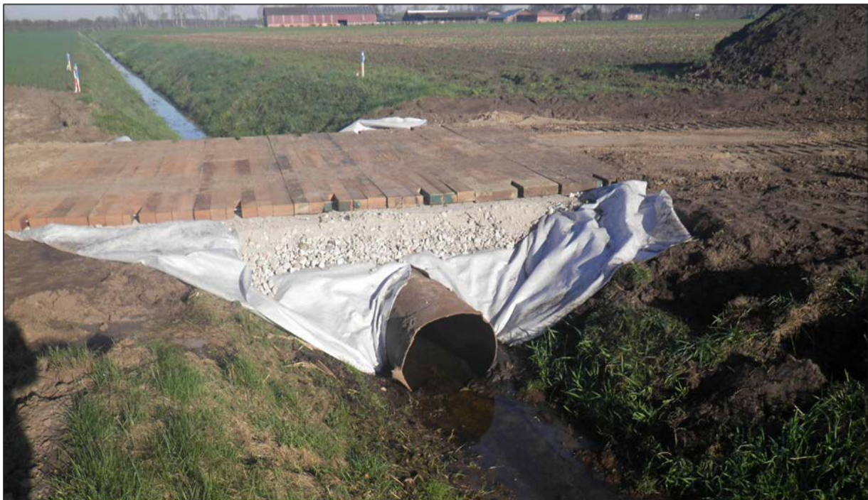
Abbildung 5: Beispiel einer Überfahrt mit temporärem Rohrdurchlass
