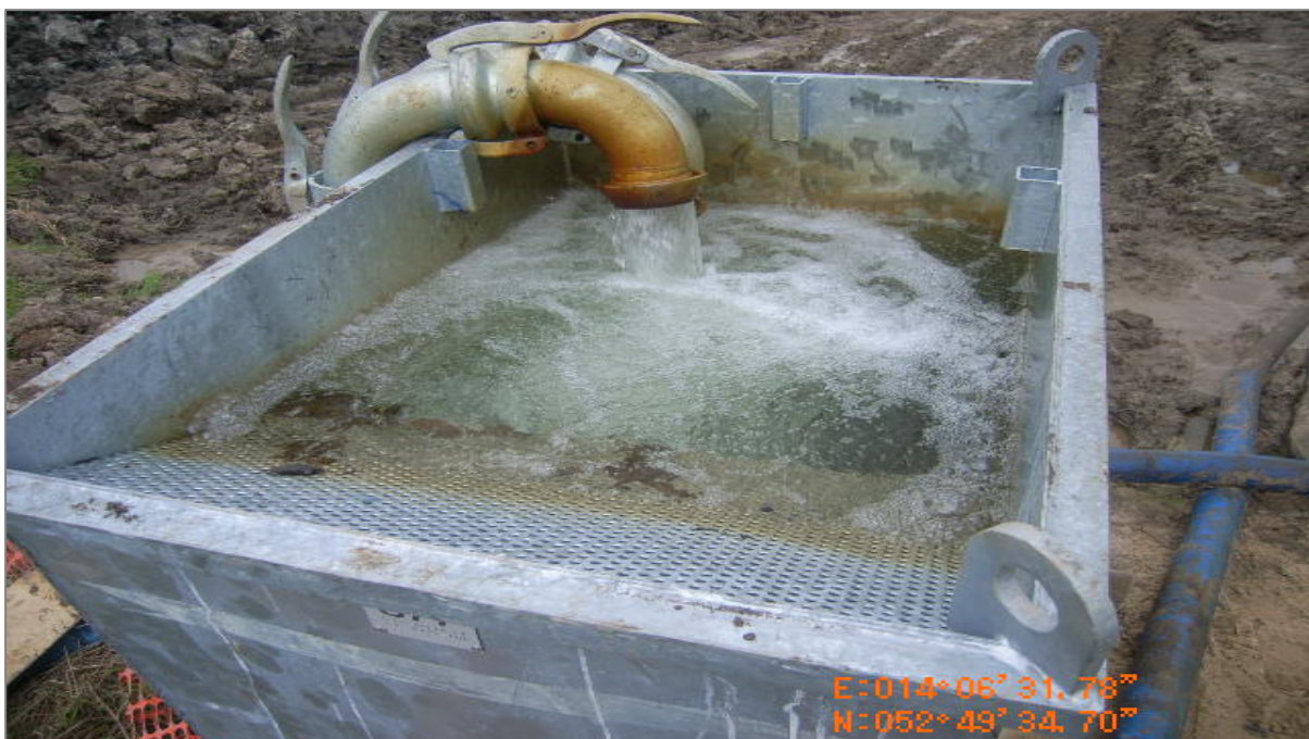
Abbildung 4: Beispiel eines vorgeschalteten Klär- und Absetzbeckens
