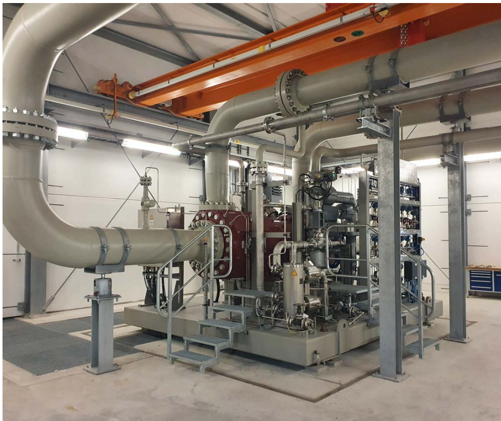
Abbildung 5: Beispiel einer Elektro-Verdichtereinheit innerhalb der Verdichterhalle
