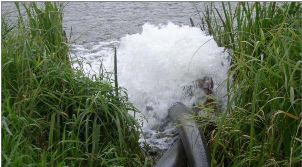
Abbildung 3: Beispiel einer Einleitung von Bauwasser
