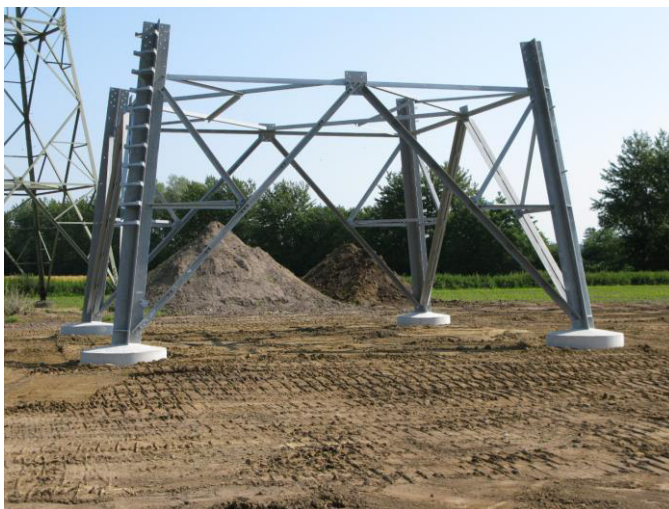
Abbildung 11: Mastfuß nach Errichtung und Anbindung an die Bohrpfähle
