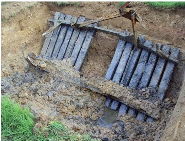
Abbildung 15: Freilegung der Schwellenfundamente
