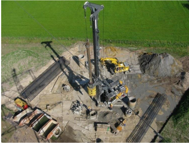
Abbildung 5: Erstellung der Bohrpfähle
