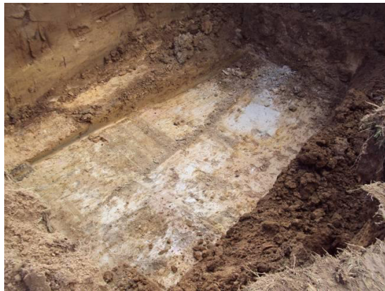
Baugrubensohle nach Aushub des belasteten Bodens
