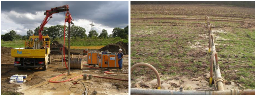
Abbildung 7: Einrichtung der Wasserhaltung mittels Spüllanzen
