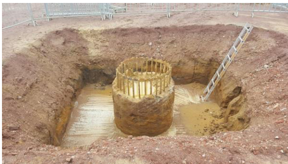
Abbildung 6: Freilegen der Bohrpfähle
