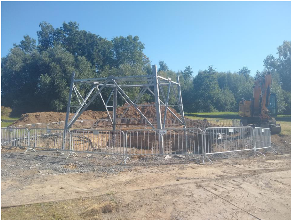
Abbildung 9: Anbindung der Eckpfähle vor dem Betonieren
