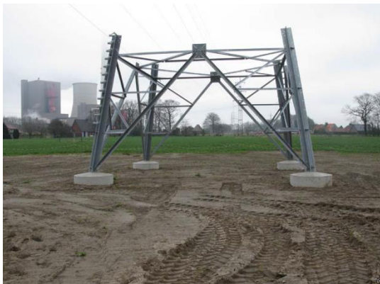
Abbildung 13: Plattenfundament nach der Verfüllung der Baugrube
