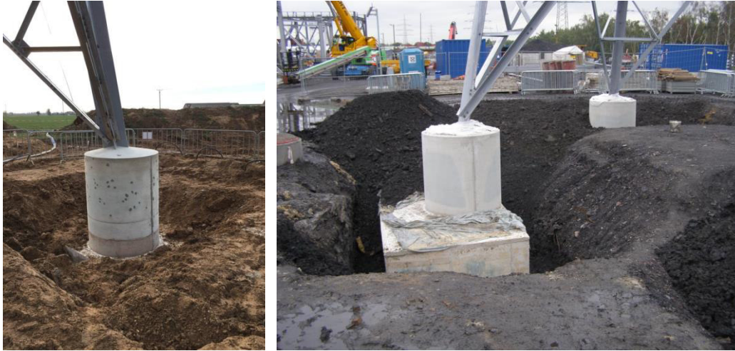
Abbildung 10: Anbindung der Eckpfähle nach dem Betonieren
