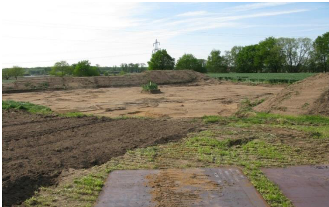
Abbildung 4: Abtrag des Oberbodens
