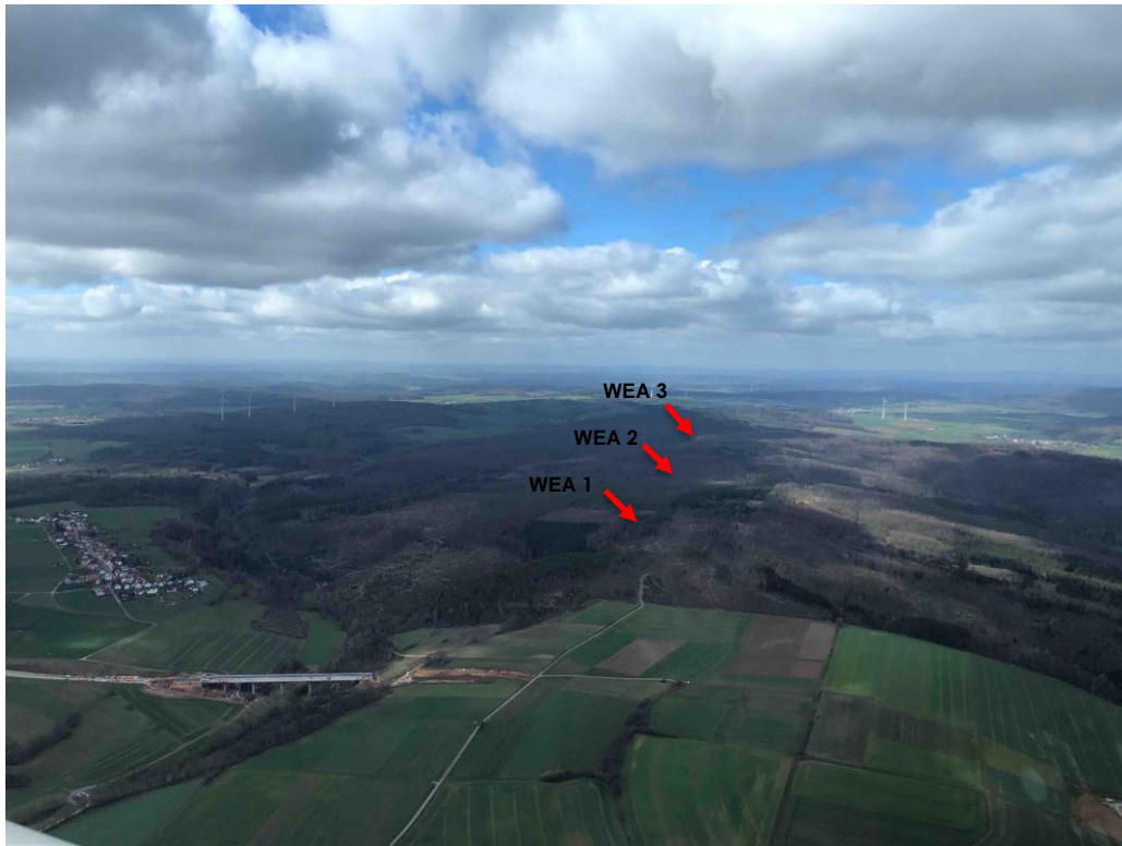
Abb.6 Blick in Richtung Westen (2.500ft MSL)
