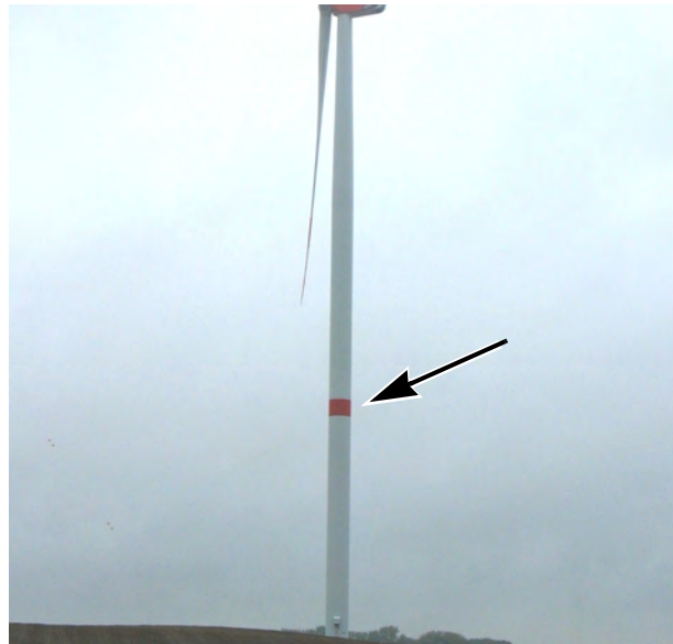
Abb. 4 Roter Farbring an Anlage mit Gesamthöhe >150 m
