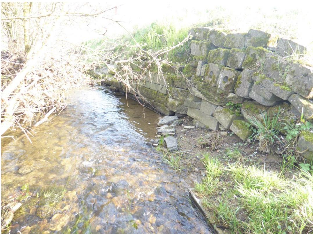
**Abbildung 2: Uferverbau mit Mauer im unteren Teil von Abschnitt 1**
