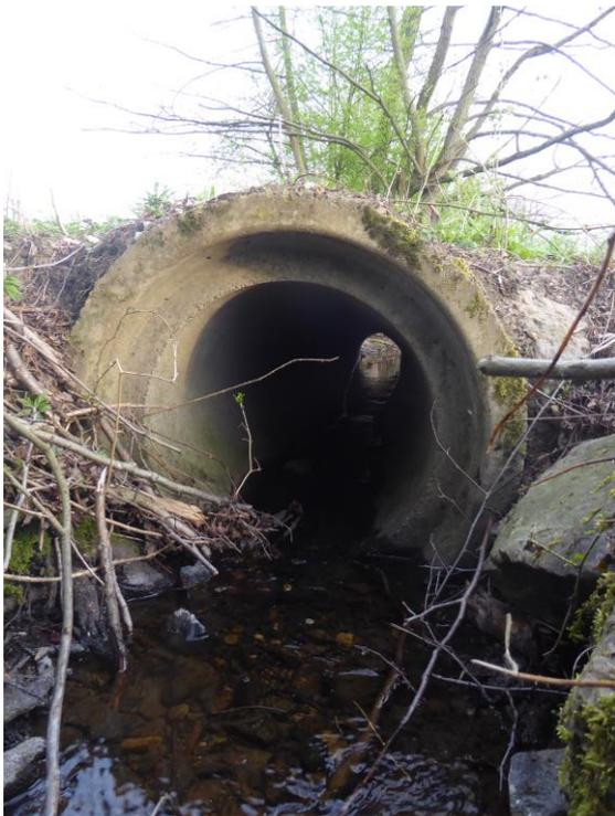
**Abbildung 22: Durchlass H2 mit glatter Betonröhre (Einlaufseite)**
