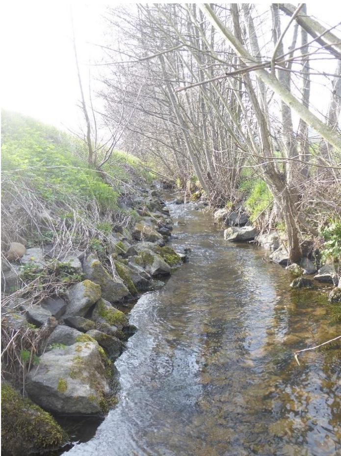
**Abbildung 1: Uferverbau mit Steinschüttung im Abschnitt 1 oberhalb der Straßenbrücke**
