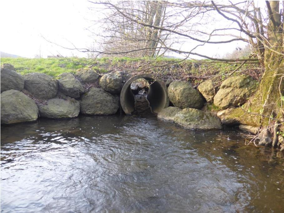
**Abbildung 19: Durchlass H3 mit glatter Betonröhre und Kolk an der Auslaufseite**
