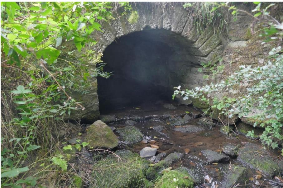
**Abbildung 18: Durchlass H4 mit verbauter Sohle am oberen Ende von Abschnitt 3 im August 2019**
