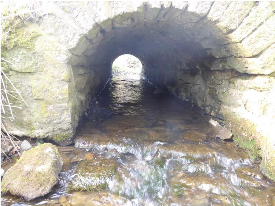
**Abbildung 17: Durchlass H4 mit kleiner Schwelle am oberen Ende von Abschnitt 3 im April 2019**
