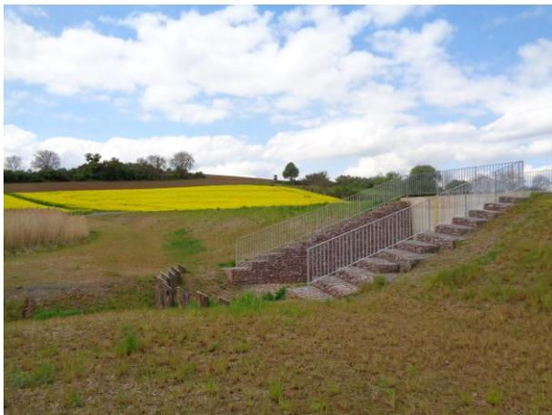
*Wasserseitige Böschung 1:3 (2017)*
