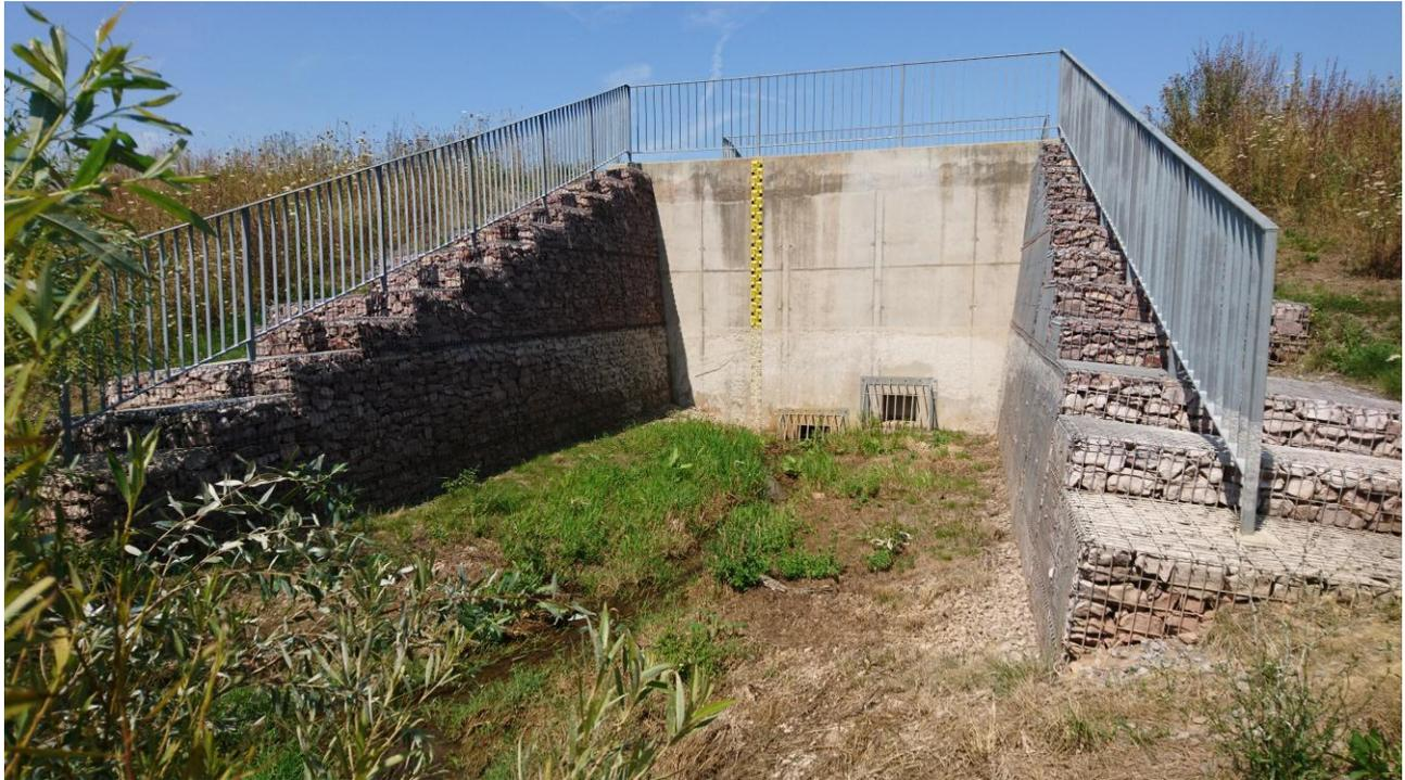
*Durchlassbauwerk - Flügelwände aus Gabionen (2019)*
