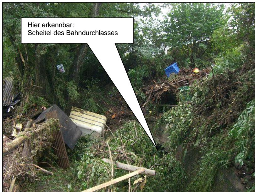
*Abbildung 7: Mit Treibgut und Geschwemmsel verlegter Bahndurchlass*
