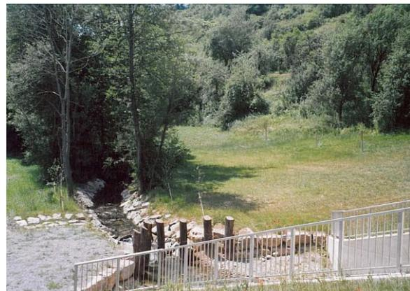
Abbildung 19: Offenes Trogbauwerk mit Steinschüttung    Abbildung 20: Einlaufseite mit Geschwemmselabweiser
