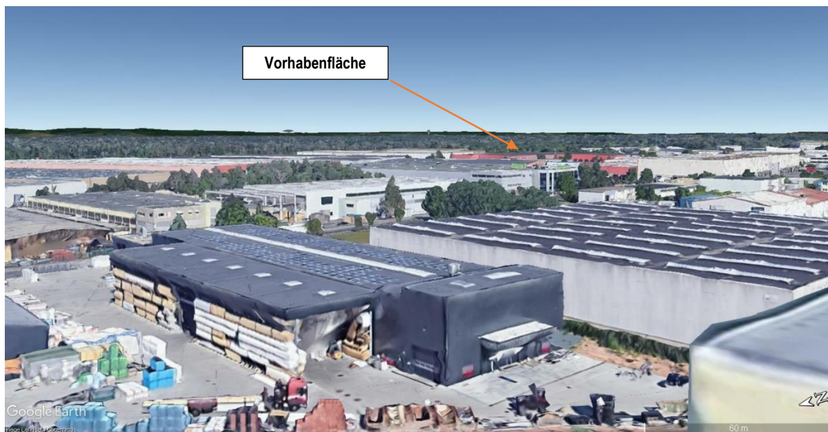
Abb. 56: Blick aus den oberen Stockwerken des Wohngebäudes an der Rheinstraße 2 auf die Vorhabenfläche (Quelle: Google Earth Pro).
