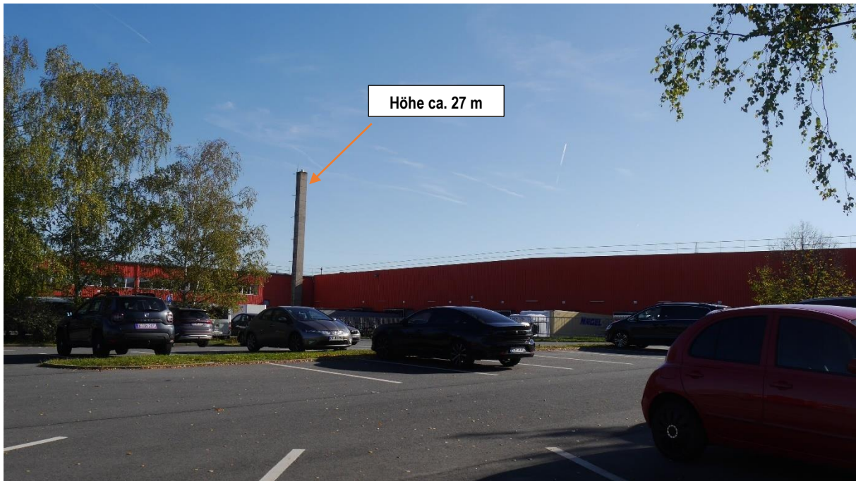
Abb. 53: Etwa 27 m hoher Schornstein am REWE-Lager an der Von-Hevesy-Straße im Kreuzungsbereich zur Robert-Bosch-Straße.
