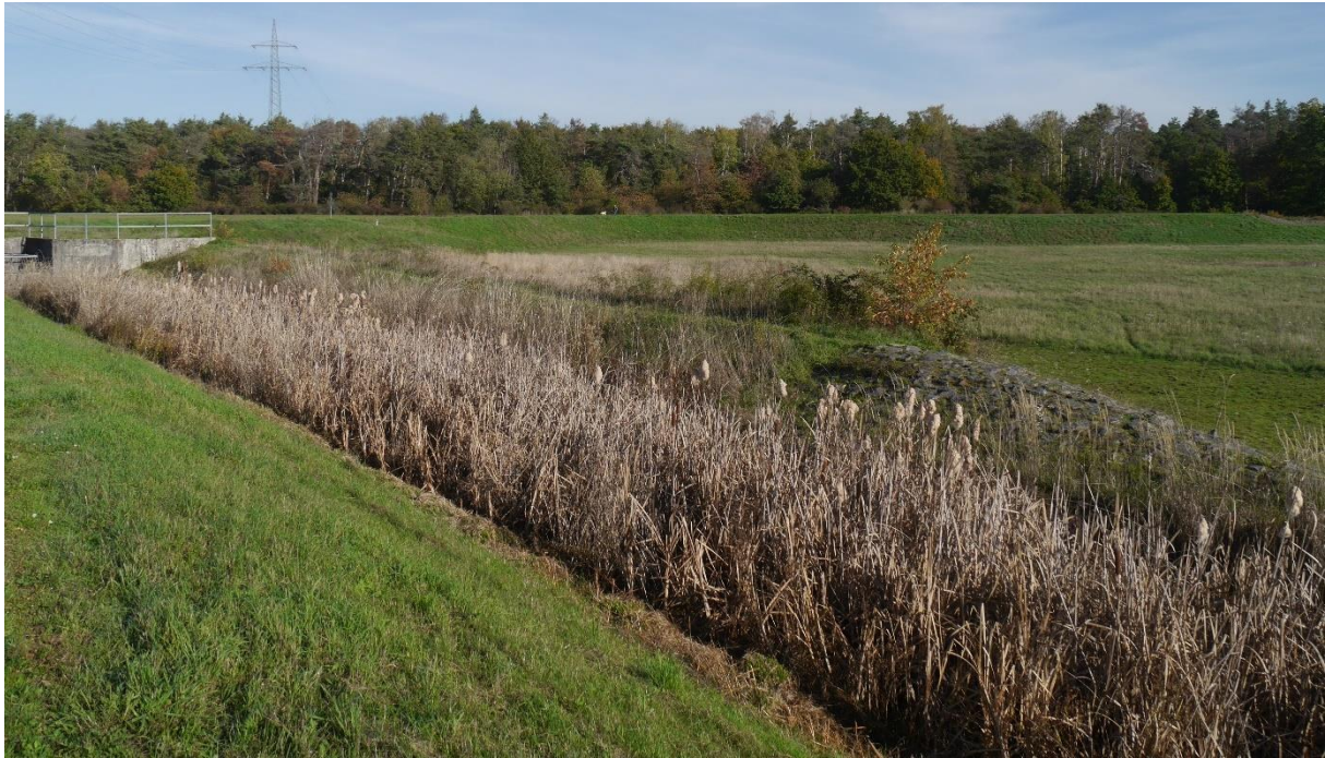
Abb. 39: Der renaturierte Abschnitt des Gehrengabens zwischen der östlichen Vorhabenfläche und dem Regenrückhaltbecken kurz vor Beginn der Verrohrung.
