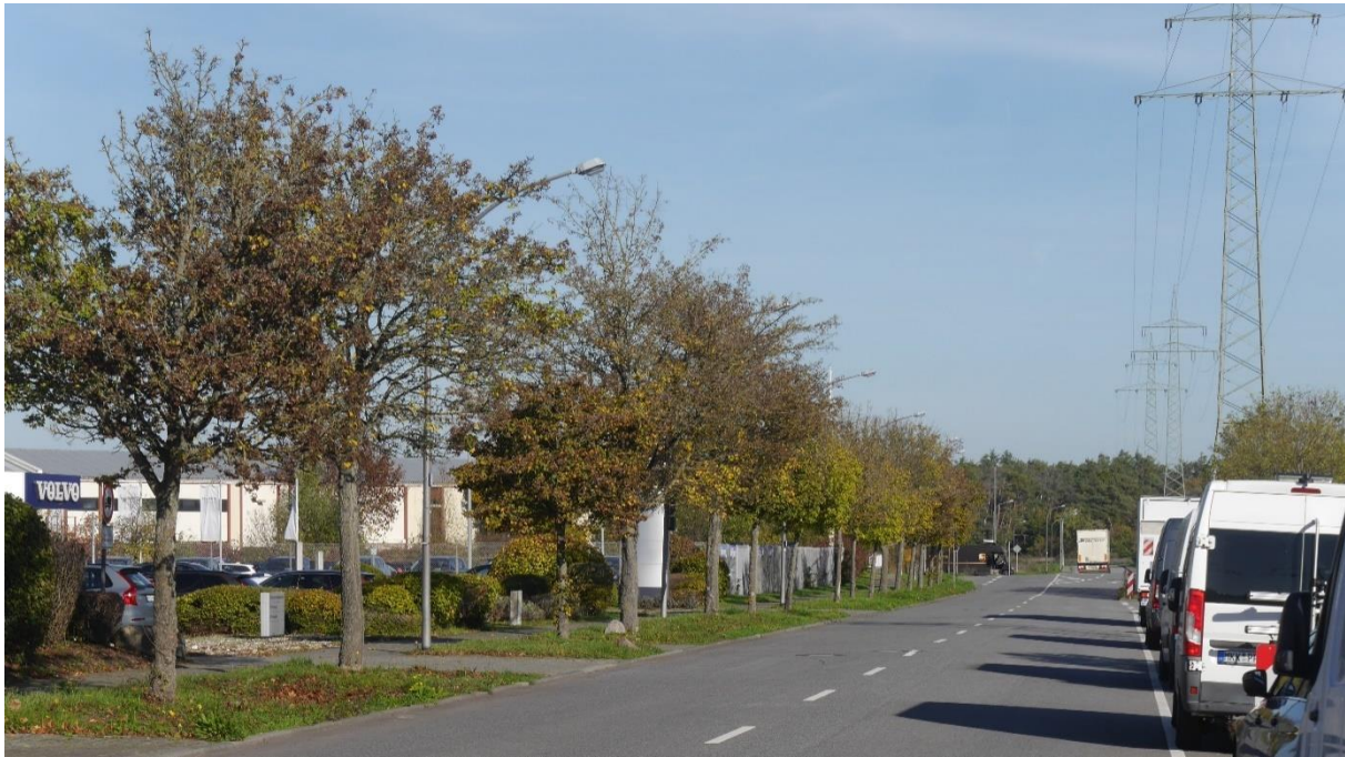
Abb. 52: Freileitung entlang der Waldstraße
