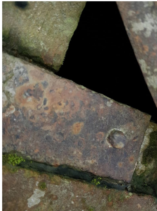
Abbildung 15: Aufsicht auf die Ecke des Schachtes Holzwiesenquelle (Lücke)
