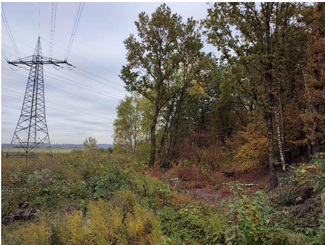
Abbildung 2: Gehölzbestand am Fuß der Westböschung
