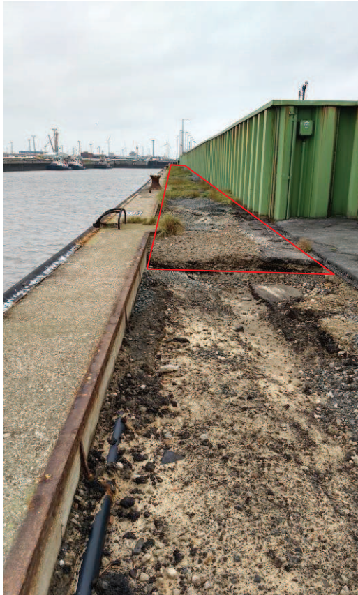
Foto 3: Überblick über die Teilfläche 8; Oberflächenbefestigung aus RC- Materialien und Schotter (rote Markierung)
