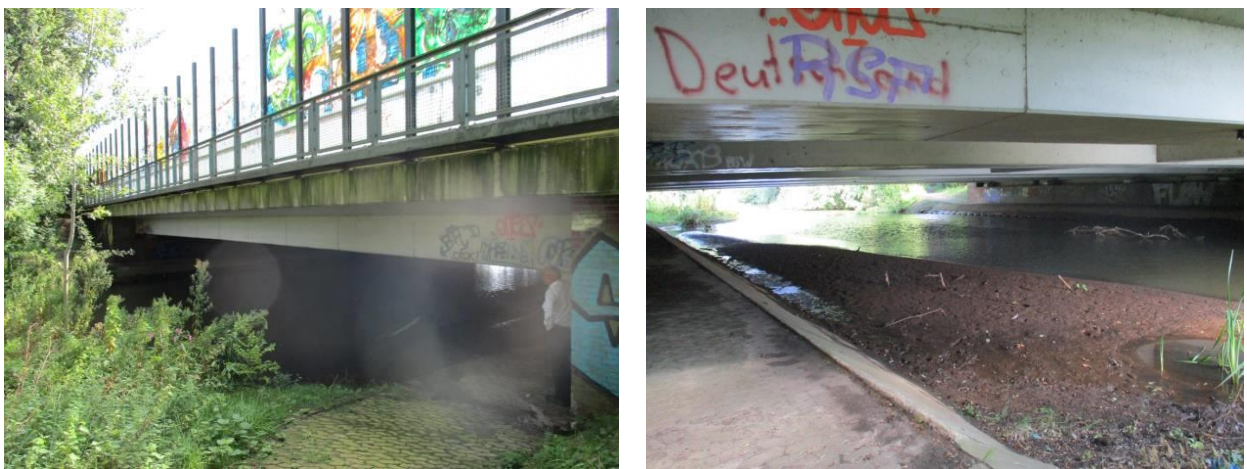
Abbildung 5: Bestehende Ochtumbrücke (Fotos: grbv)
