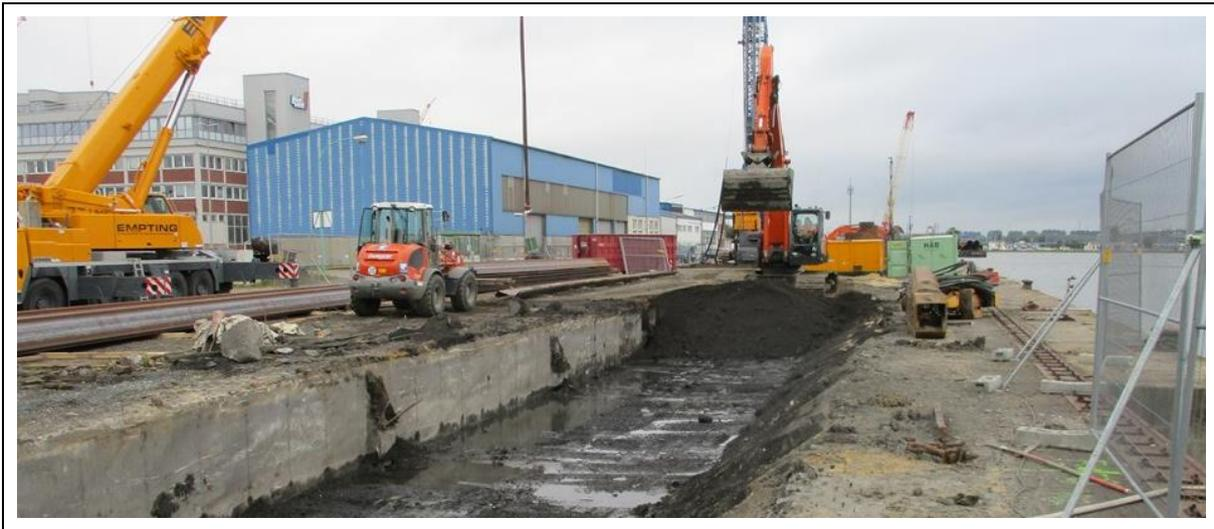
**Abbildung 10: Beispiel Aushub im Bereich der Rammtrasse (1. BA)**
