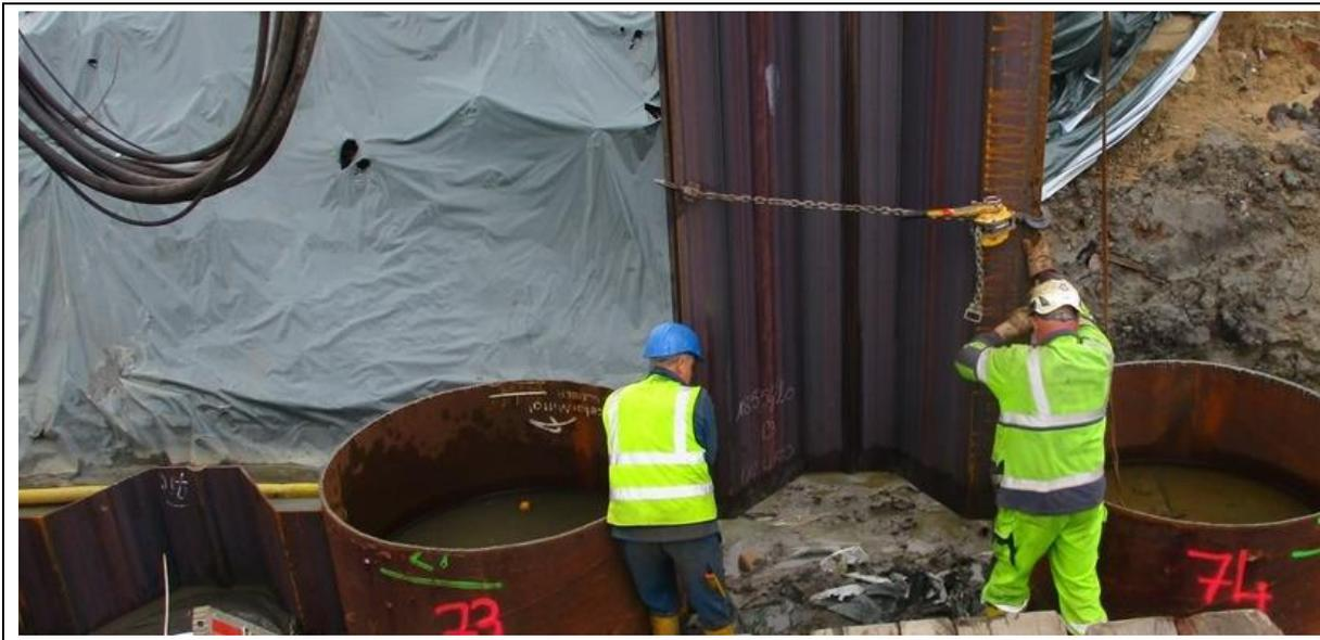
**Abbildung 12: Beispiel Einbringen der Füllbohlen (1. BA)**
