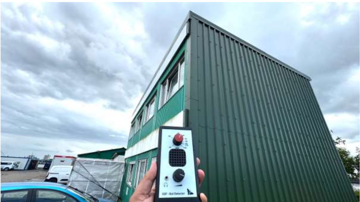
Abb. 7: Der Bürocontainer hat keine Eignung als Fledermausquartier, da eine Temperierbarkeit aufgrund der Dünnwandigkeit der Trapezbleche nicht gegeben ist, Aufnahme: 01.07.2024
