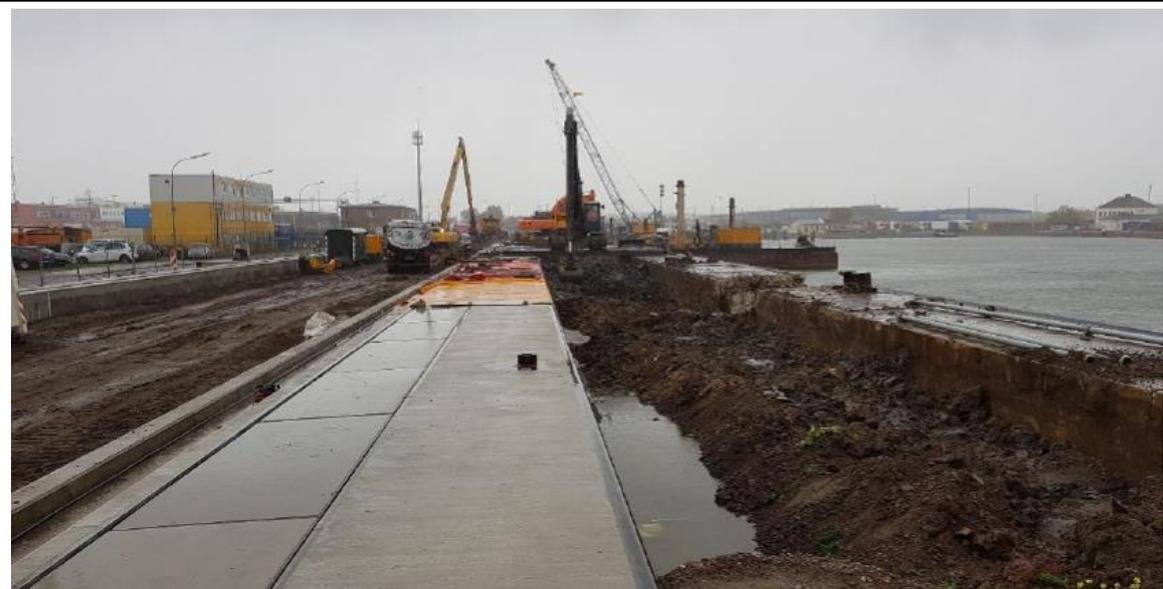
**Abbildung 19: Aushubarbeiten Kajenhinterfüllung (1.BA)**
