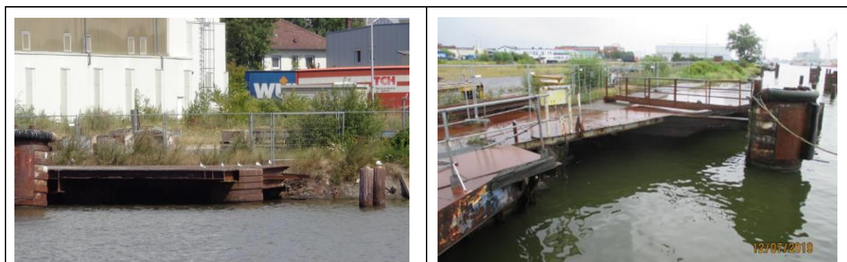
Abbildung 7: Ehemaliger Stahlüberbau und Dalben
