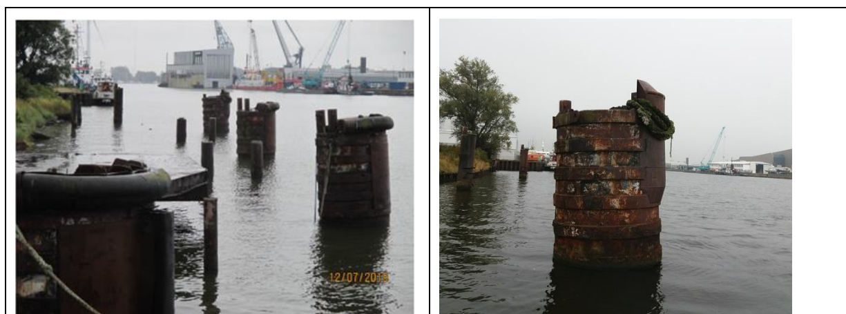
Abbildung 13: Dalben und Anlegedalben mit Lamellen
