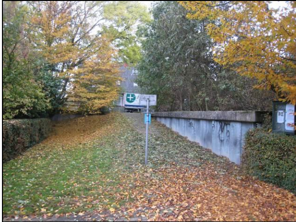
Abb. 6: Überfahrt Kompassweg mit verschwenkender Spundwand bei Station 0+432
