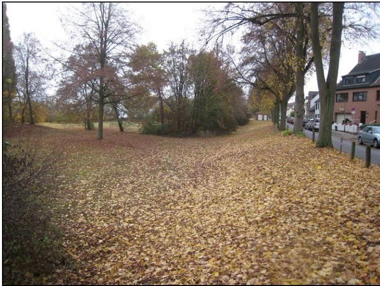
Abb. 9: Deich zwischen Treppenbauwerk und Gasregelstation, Blickrichtung Süden
