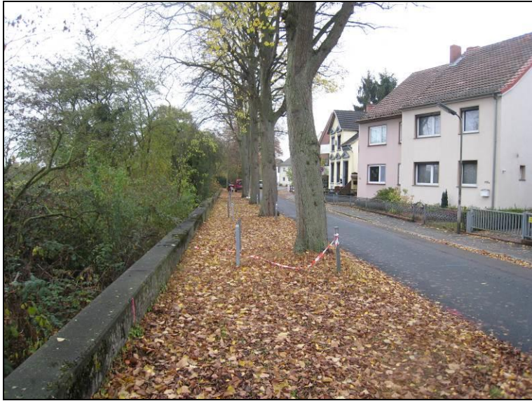
Abb. 5: HWS-Spundwand am Westerdeich, Blickrichtung Osten
