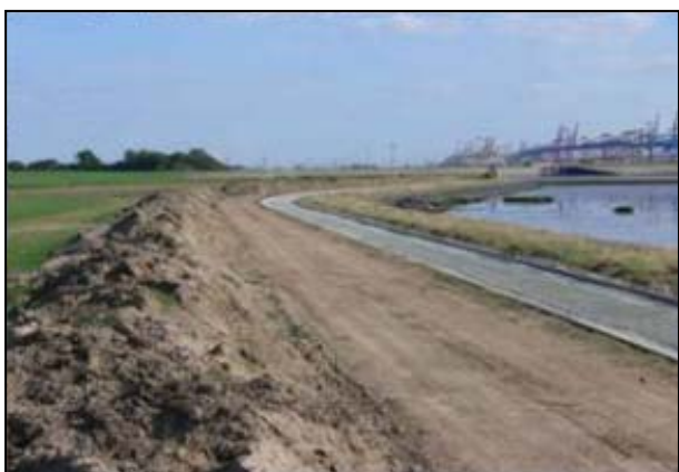
Foto 5: Baumaßnahmen am Deckwerk nördl. der 1. Buhne (asphaltierter Weg und Arbeitsstreifen / Bodenlagerung)
