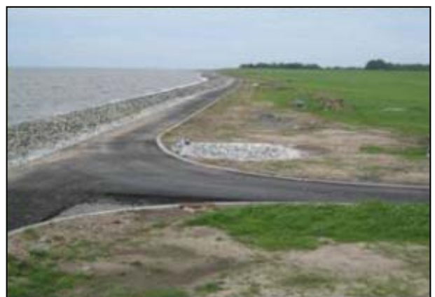
Foto 6: Neubau Deckwerk (verklammerter "Steinwall") mit zusätzlichem Fahrstreifen; Zu-/Abluss-Rohre; nördl. des Planungsbereichs
