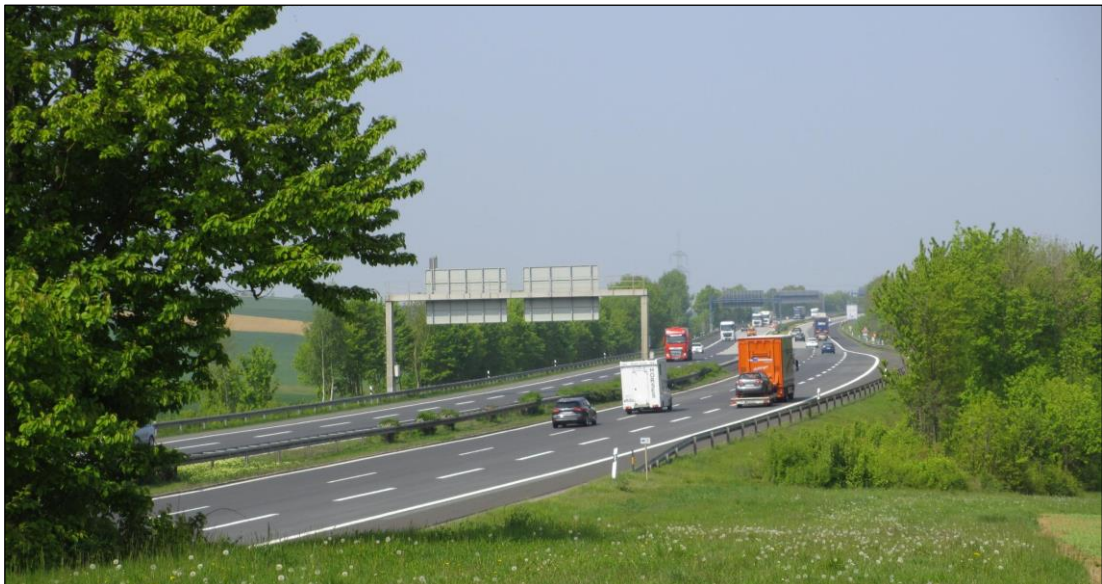
Abbildung 3 Blick auf Bezugsraum 1 auf einen Ausschnitt der Autobahn A7 mit Verkehrsbegleitgehölzen; Foto: arc.grün, 2019
