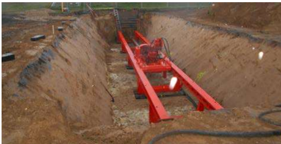
Abbildung 11: geschlossene Querung einer Straße mittels Horizontal-Pressbohrverfahren
