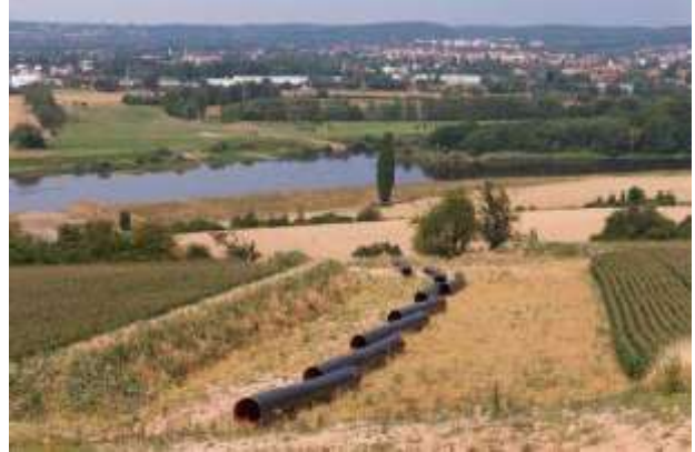
Abbildung 9: Auslegen längs der Trasse
