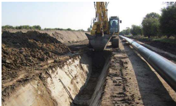
Abbildung 12: Grabenaushub
