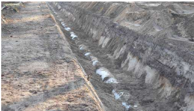
Abbildung 15: Teilverfüllung des Rohrgrabens
