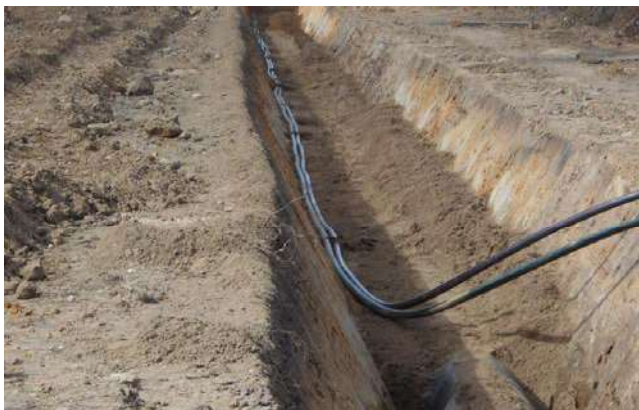
Abbildung 16: Verlegung Kabellehrrohre in offener Bauweise
