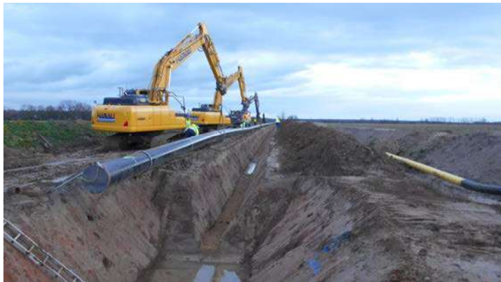
Abbildung 13: Absenken des Rohrstranges
