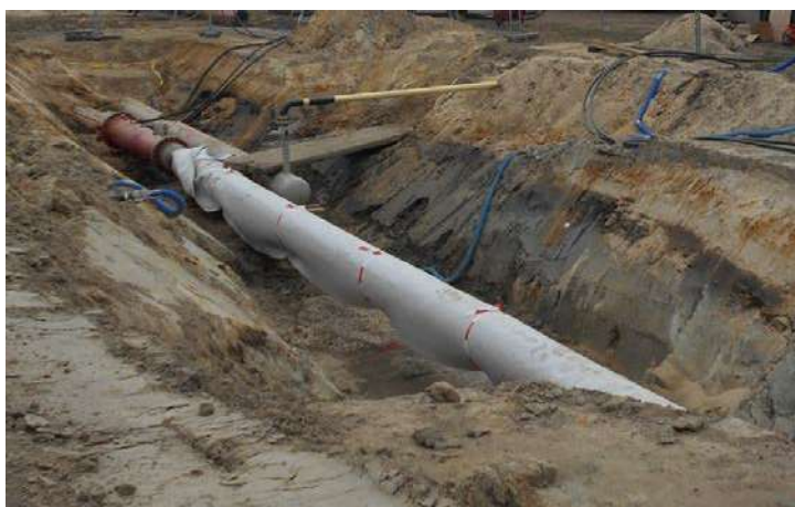
Abbildung 18: Wasserdruckprüfung
