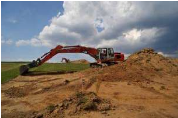
Abbildung 7: Abtrag Oberboden
