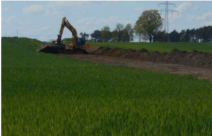
Abbildung 19: Oberflächenwiederherstellung
