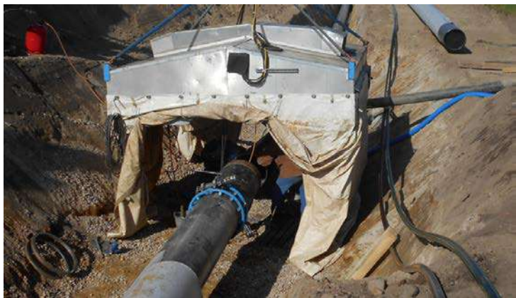
Abbildung 14: Verschweißen zweier Rohrstränge
