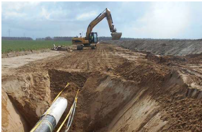
Abbildung 17: Restverfüllung des Rohrgrabens
