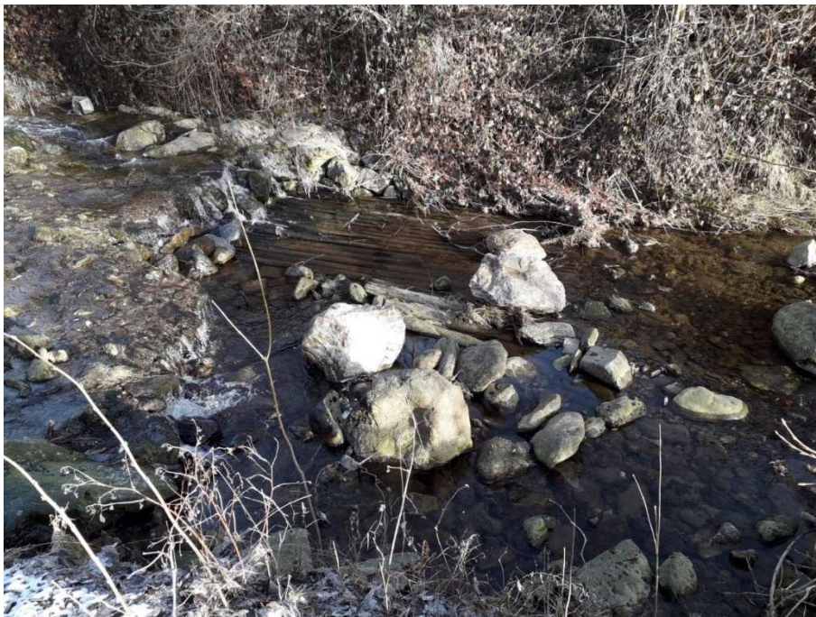
Foto: Sohlabsturz und Sohlsicherung mit Balkenlagen
