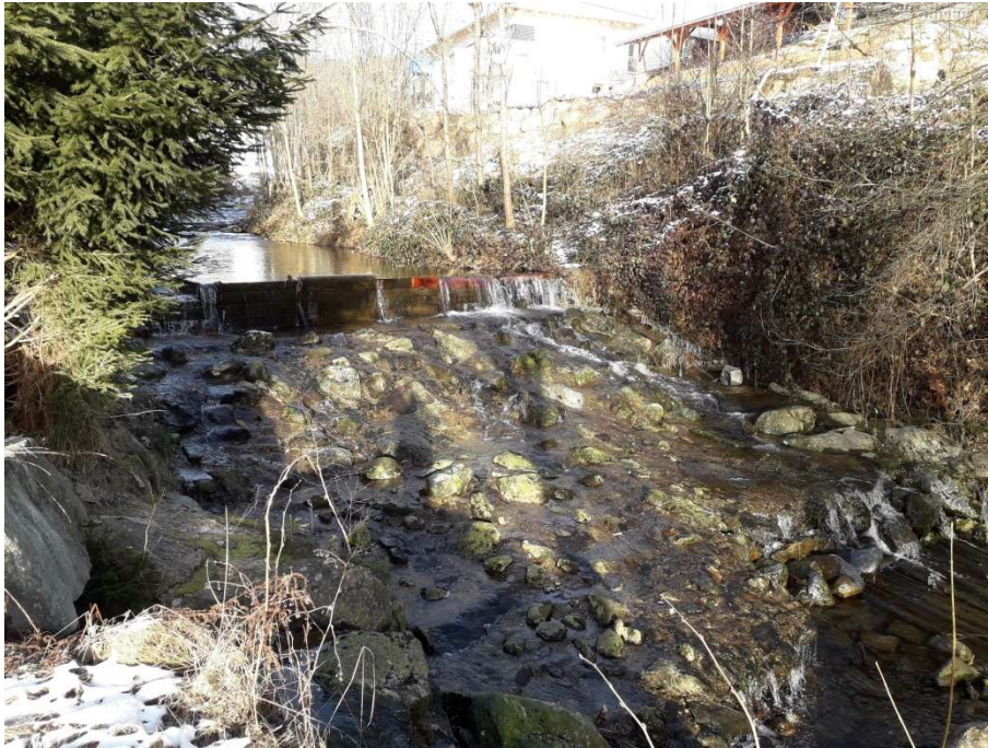
Foto: Bestehende Wehranlage mit Sohlrampe
