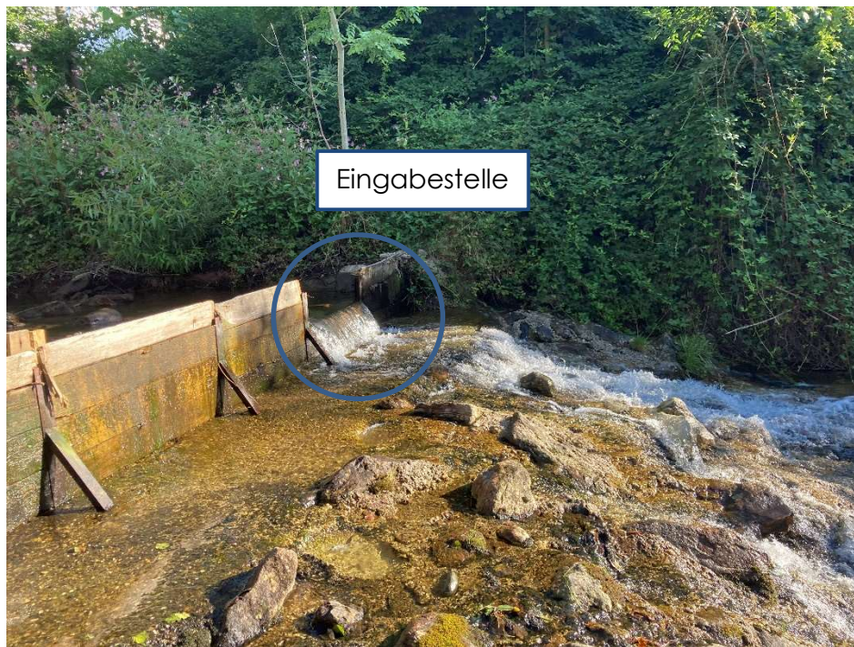
Abbildung 2: Wehr vor der bestehenden Ausleitstrecke, Eingabestelle Tracerversuch markiert (Foto: IB Pfeffer)
