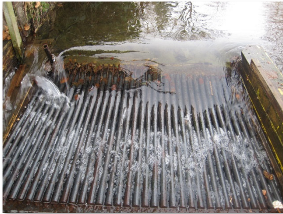
Abb. 2: Rechen am Einlaufschacht der Wehranlage
