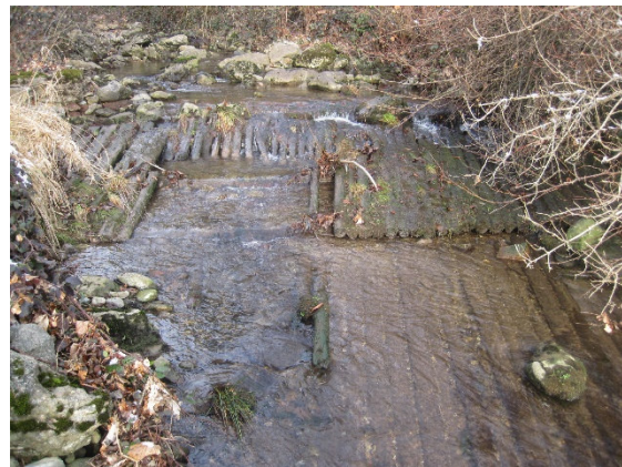
Abb. 13: Sohlstabilisierung mit Holzbalken in der Mitte der Restwasserstrecke
