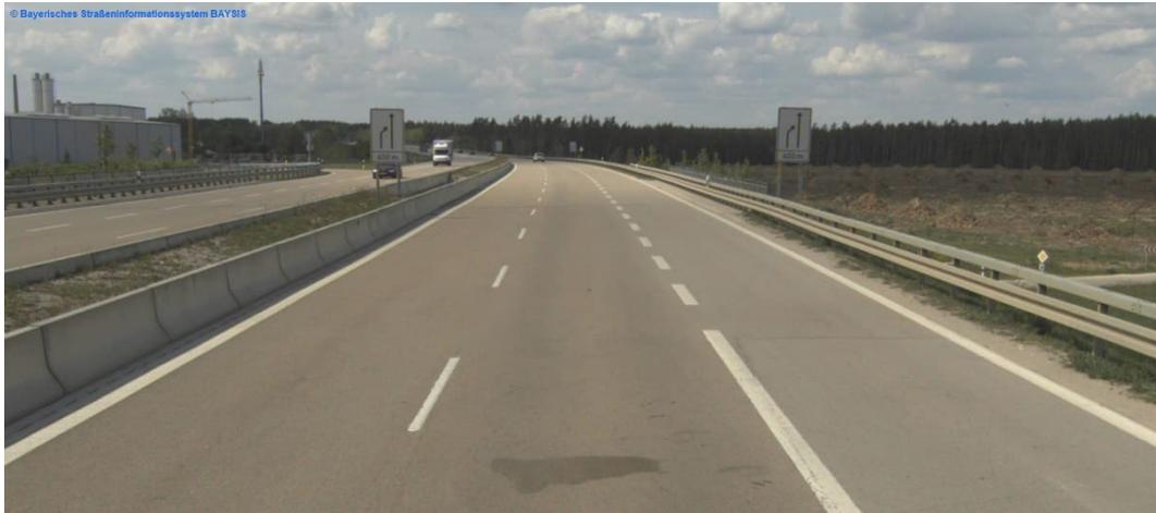
*Bild 13: Überlagerung der Vorankündigung „Linkseinzug“ mit dem Einfädelsstreifen im Bestand*
