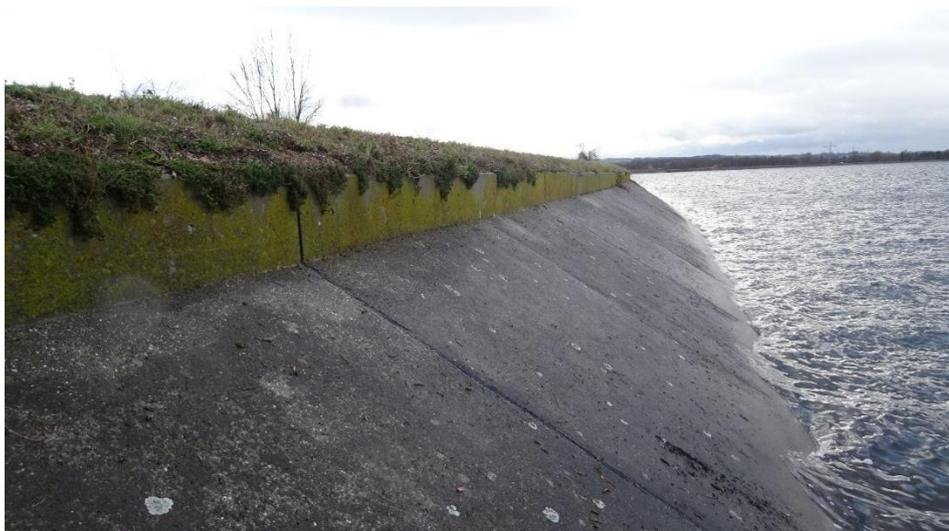
Abbildung 14: Aufsatzmauer an der Dammkrone
