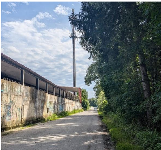
Abbildung 24, Rückansicht der Schüttboxen. Im Norden davon, ein schon bestehendes Dach, sowie einem Funkmast, rechts die hohe umgebende Gehölzstruktur
