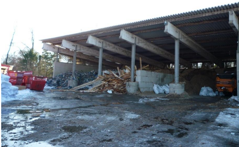
Abbildung 3, Schüttgutboxen im Norden der Anlage, Blickrichtung Norden, 07.12.2023
