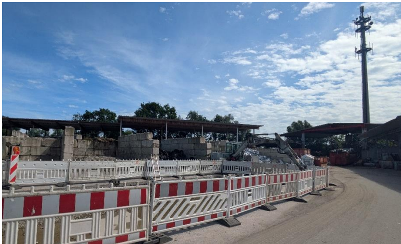
Abbildung 2, Überdachte und nicht überdachte Schüttboxen im (Nord)osten, Telekommunikationsmasten im Hintergrund, Blickrichtung Osten, 26.06.2024
