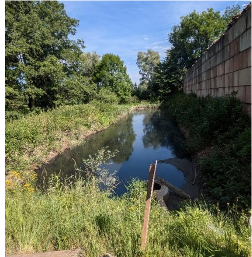
Abbildung 5, Retentionsbecken im Nordwesten der Anlage, Blickrichtung Norden, 26.06.2024
