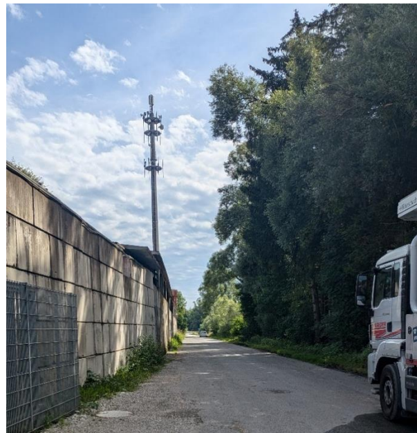
Abbildung 10, Südwestliche Mauer der RC-Anlage und angrenzendes FFH-Gebiet Auer Weidmoos, Blickrichtung Osten, 26.06.2024
