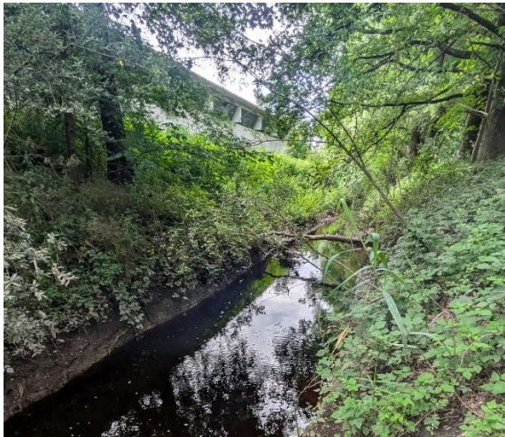
Abbildung 13, Lungelbach, links die Außenmauer der RC-Anlage, Blickrichtung Süden, 26.06.2024
