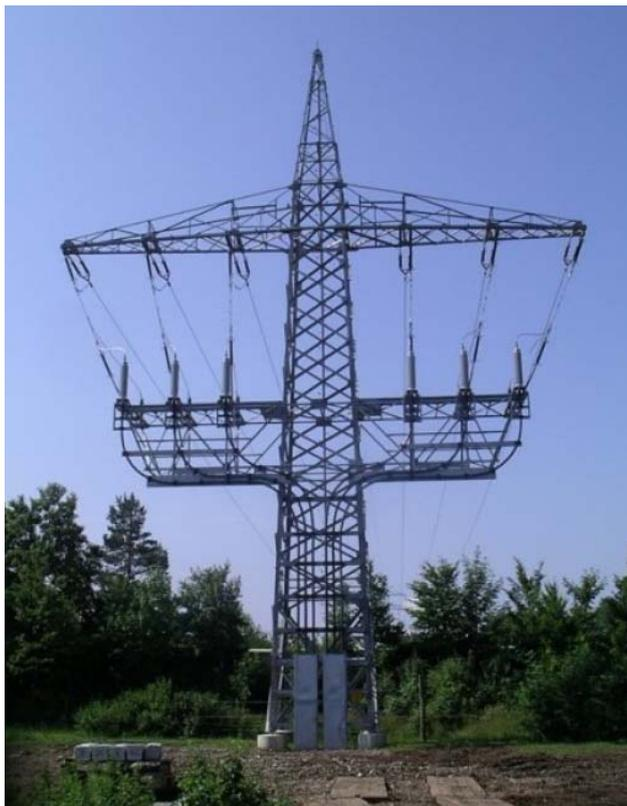
Abbildung 4: Bsp. Kabelübergangsmast
