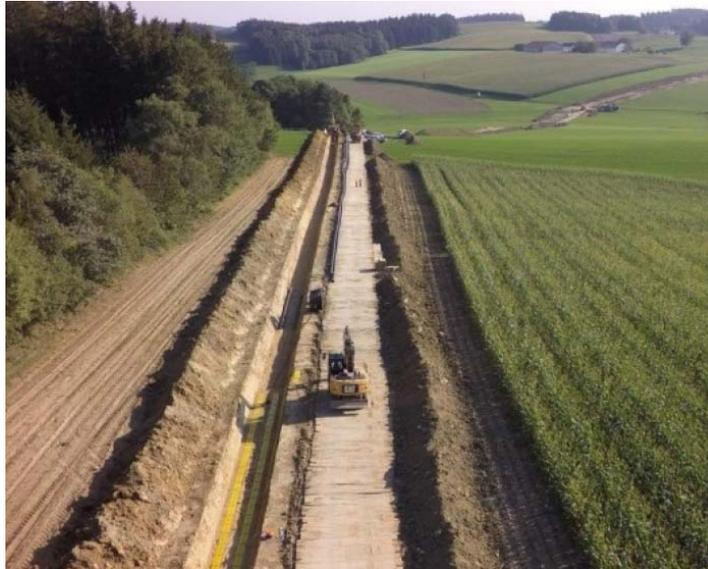
Abbildung 4: Bsp. Kabelverlegung mit offener Bauweise
