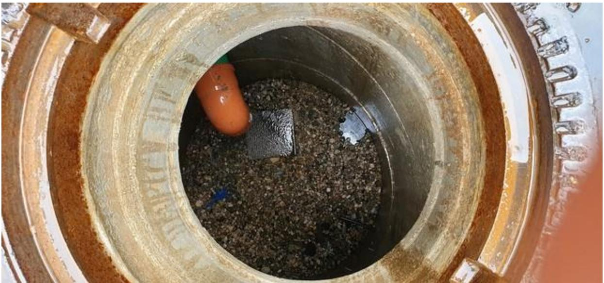
4. Gereinigter Versickerungsschacht mit sichtbarer Filterschicht nach Reinigung.
