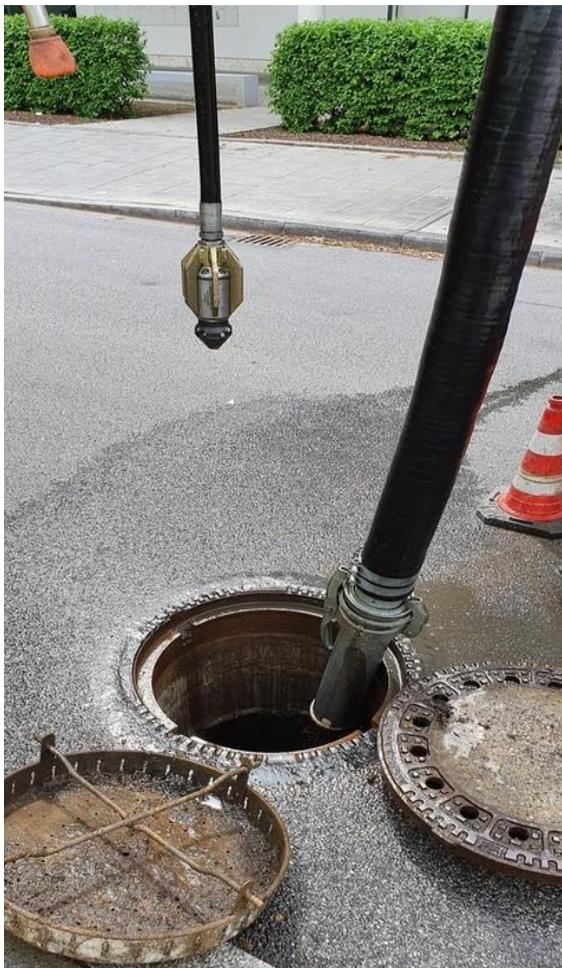
2. Spüldüse und Saugschlauch werden in den Versickerungsschacht eingeführt.
