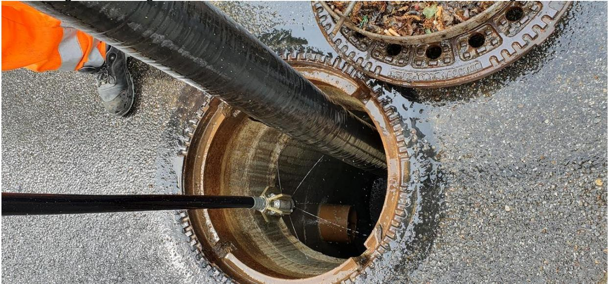
3a. Reinigung des Absetzschachtes mit der Spüldüse und Absaugen des zur Reinigung genutzten Wassers und des davor verbliebenen Schlammes.
