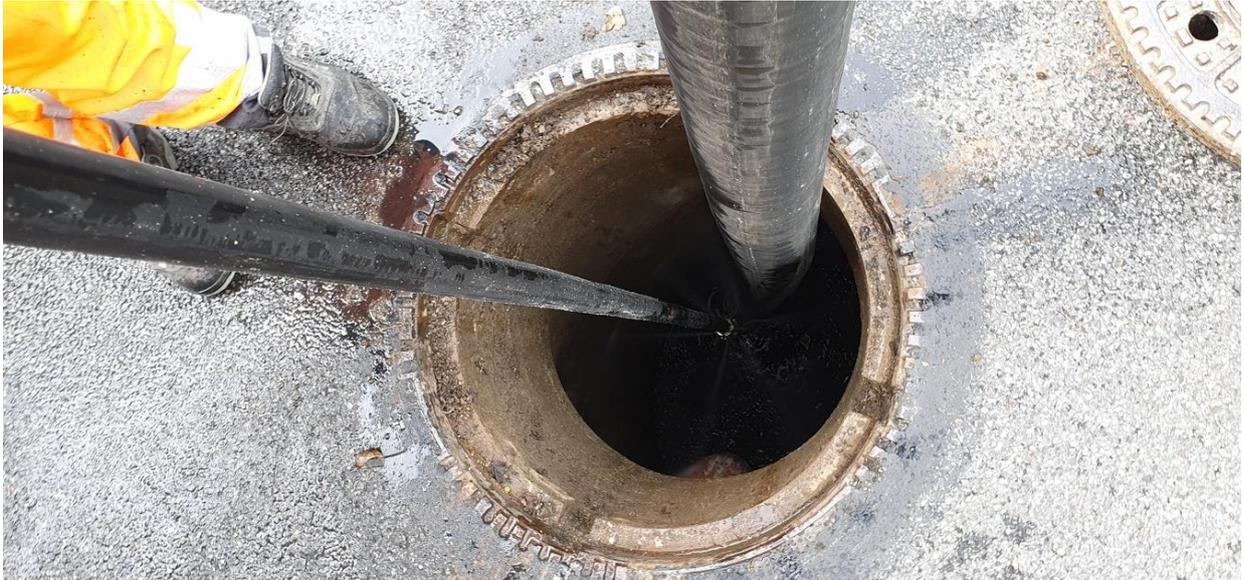
3. Durch den Hochdruckwasserstrahl wird die Inkrustation sowie das abgesetzte Material gelöst und mit dem Saugschlauch abgesaugt.
