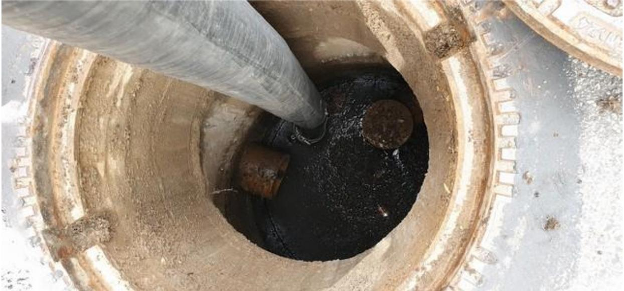
2. Absaugen des eingestauten Wassers und der Grobstoffe mit dem Saugschlauch.
