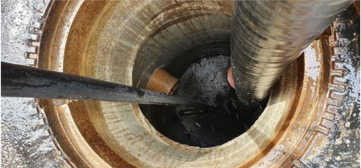
3b. Gereinigter Absetzschacht: Betonbodenplatte sichtbar.
