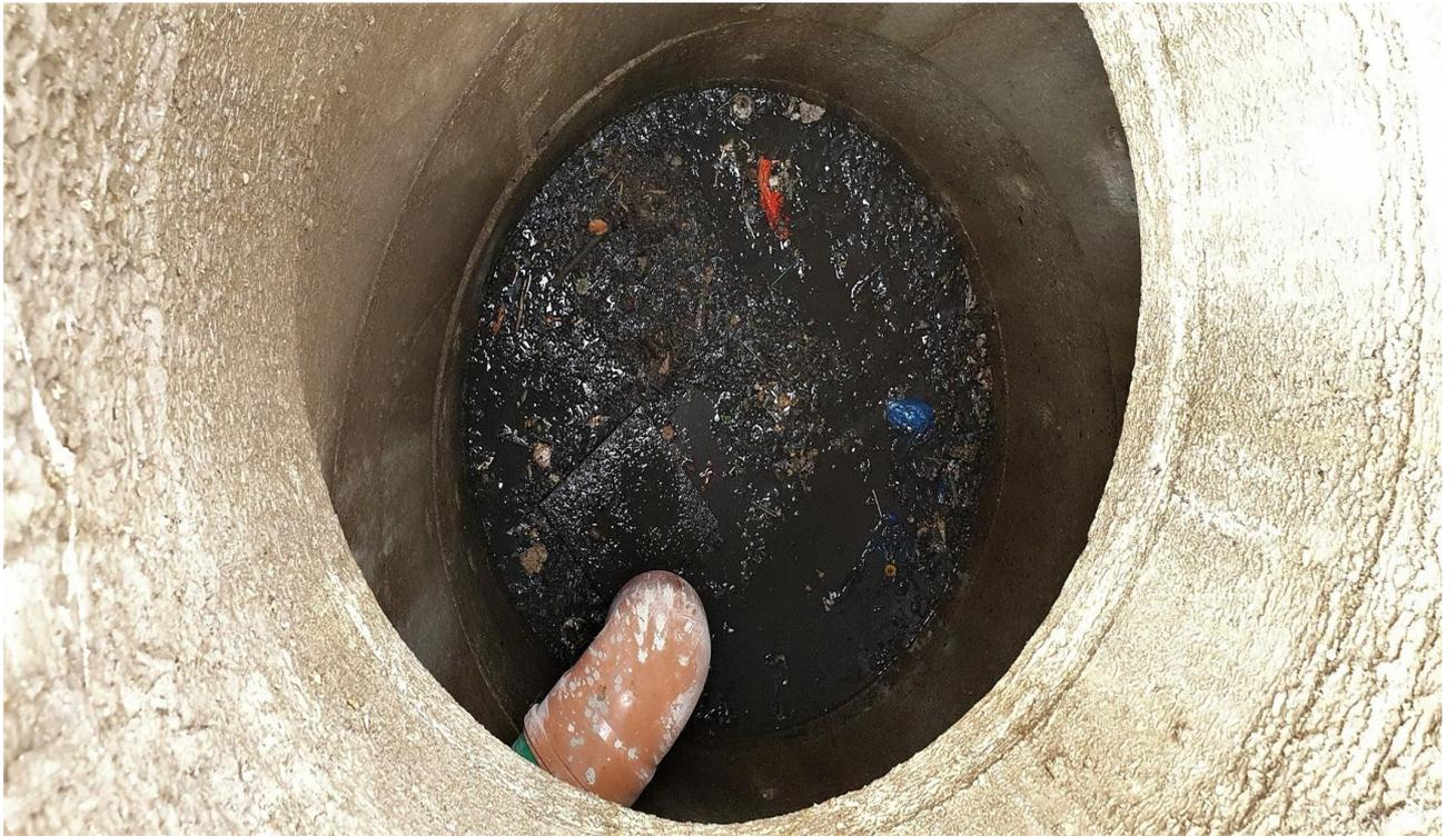
1. Ungereinigter Versickerungsschacht mit Prallplatte und Zulauf vom Absetzschacht.
