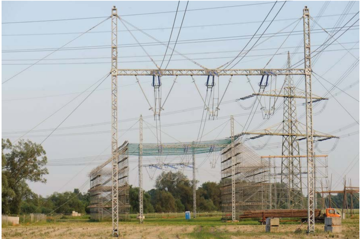
Abbildung 12. Beispiel eines Schutzgerüsts mit Provisorium.
