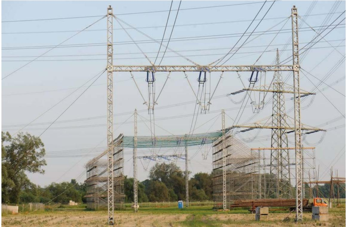
Abbildung 12. Beispiel eines Schutzgerüsts mit Provisorium.
