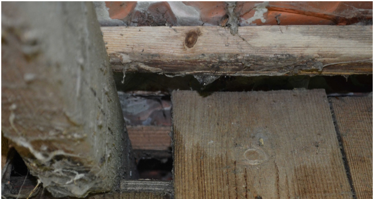
Abb. 8: Einflugmöglichkeit in den Dachstuhl der Holzhütte.
