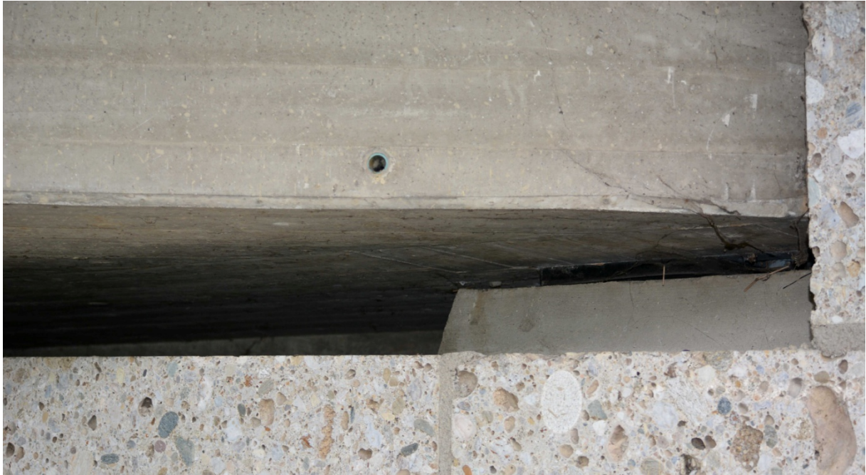
Abb. 14: B299 Brücke: Typischer horizontaler Hohlraum im Tragwerk der Brücke, z. T. für Marder, Katze, etc. zugänglich. Eignung für Fledermäuse unwahrscheinlich; als Nistplatz für Vögel möglich.
