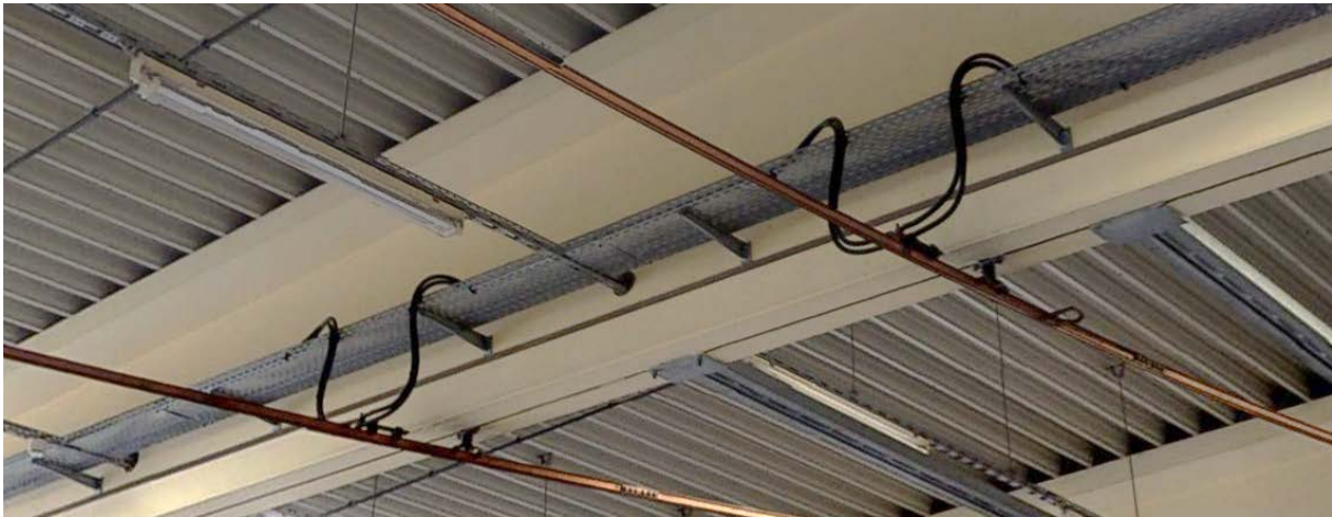
Abbildung 22: 3D-Scan Deckenstromschiene Abstellhalle (Bau 1 BT 1)
