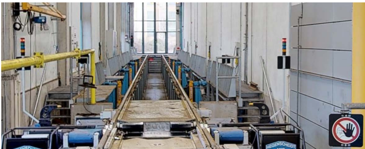
Abbildung 18: 3D-Scan Gitterroste und Fahrzeug-Hebeanlage Gleis 10
