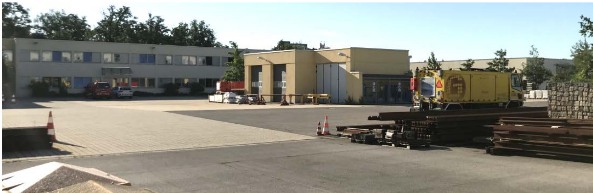
Abbildung 28: Bereich Fahrweg Bau 5, Maschinenhalle Bau 4, Gleisbauplatz
