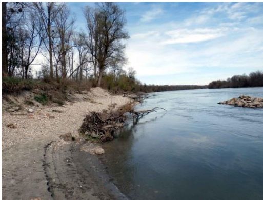
Abbildung 3-9: Bestehender Uferrückbau unterhalb der Straßenbrücke.
