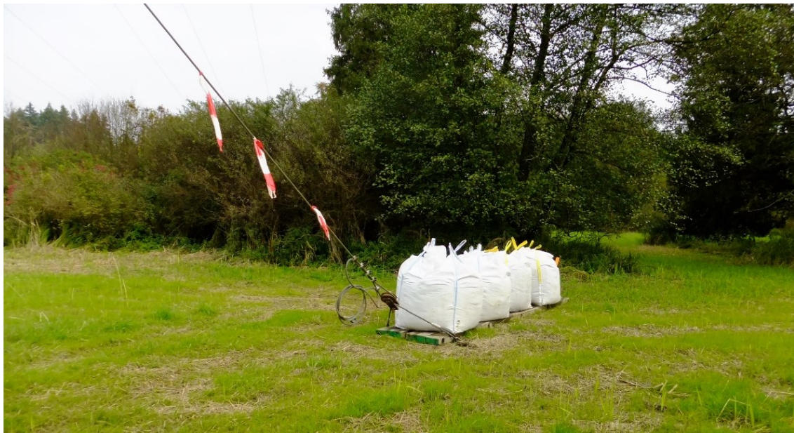
Abbildung 16: Abankerung mittels Ballastschlitten
