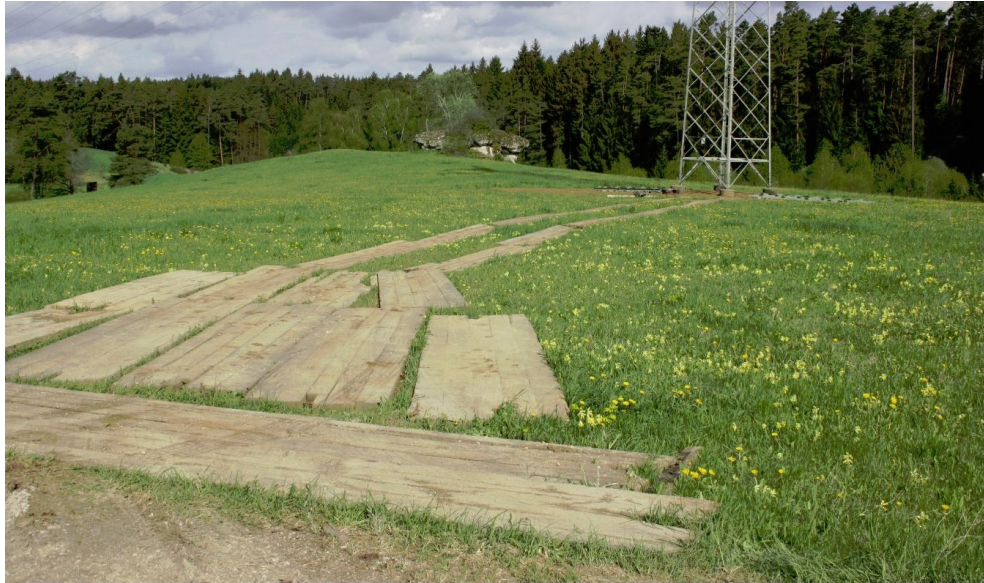
Abbildung 11: Zuwegung über Holzplatten (leichter Wegebau)
