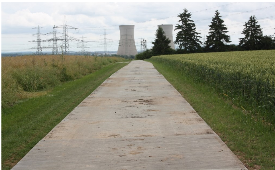
Abbildung 10: Zuwegung über Aluplatten (schwerer Wegebau)
