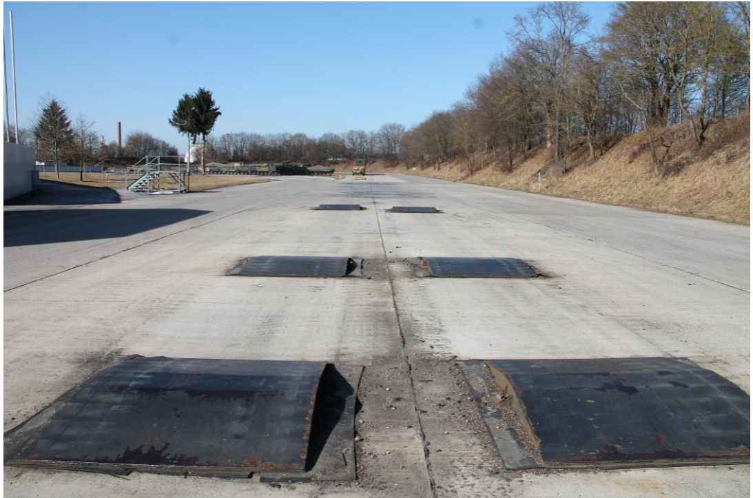
Foto 3: Blick von der Mitte der APG-Bahn in Richtung Nordwesten zur nordwestlichen Wendeschleife der Panzerteststrecke
