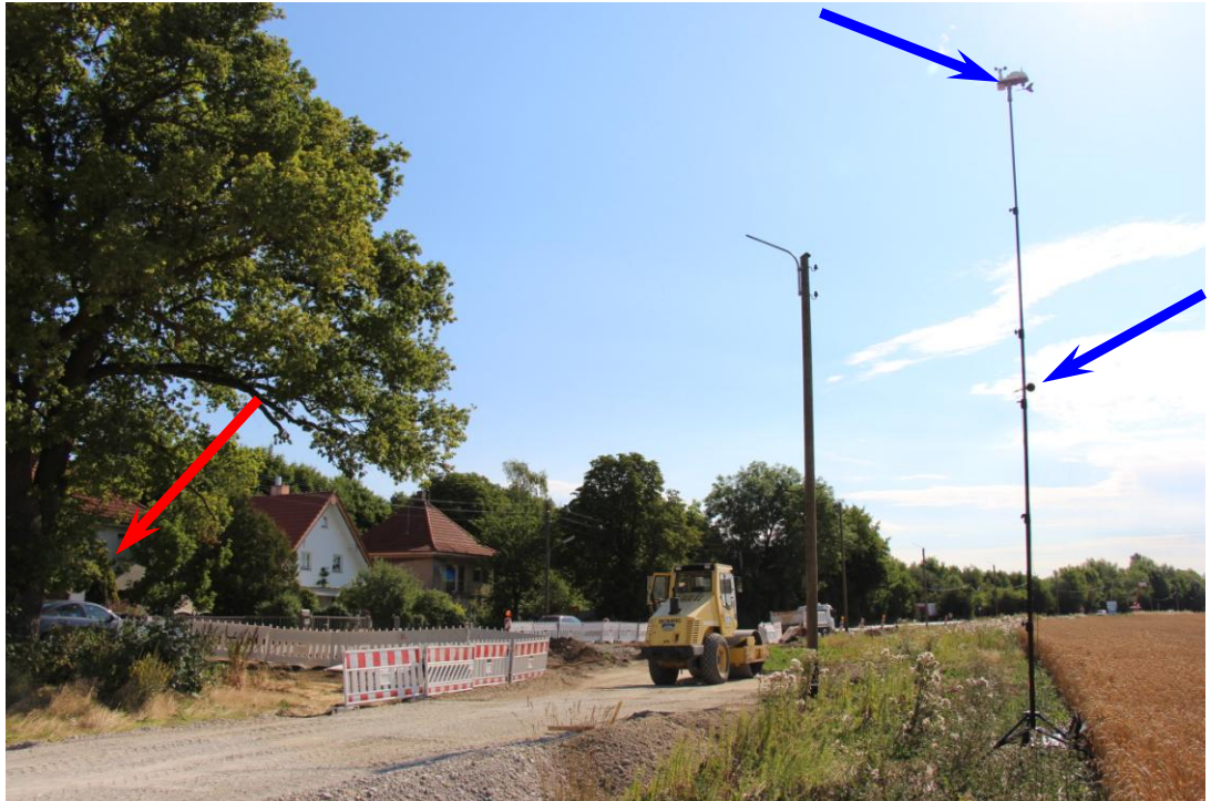
Foto 19: Blick in Richtung Nordosten auf die Südfassade (roter Pfeil) des Wohngebäudes IO 5 „Ludwigsfelder Straße 49“, das sich im Außenbereich befindet. Der Standort des Messmikrofons in h = 5,5 m Höhe über Gelände ebenso gekennzeichnet (unterer blauer Pfeil) wie der Standort der Wetterstation der Fa. Davis am oberen Ende des Stativs.
