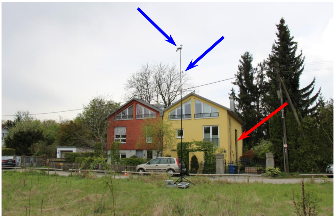
Foto 16: Blick in Richtung Westen auf die Nordfassade (roter Pfeil) des Wohngebäudes IO 3a „ Hehnstraße 9 “. Der Standort des Messmikrofons in h = 7 m Höhe über Gelände ist ebenso gekennzeichnet (unterer blauer Pfeil) wie der Standort der Wettermessstation der Fa. Davis am oberen Ende des Stativs
