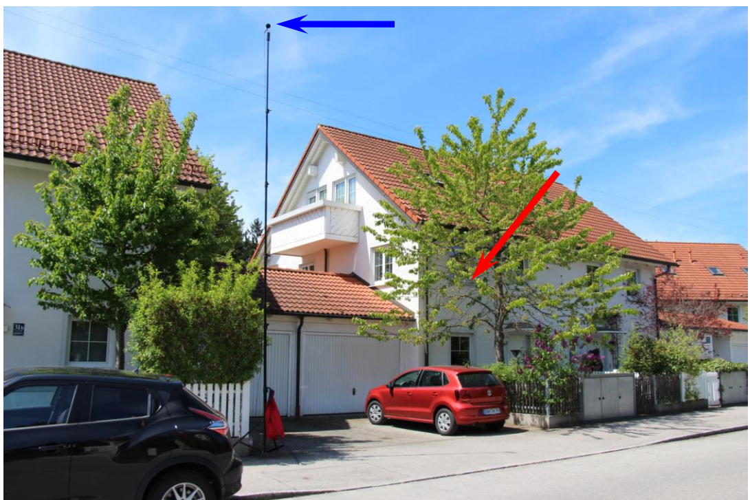
Foto 12: Blick in Richtung Nordwesten auf die Ostfassade (Pfeil) des Wohngebäudes IO 2a „Georg-Reismüller-Straße 31c“ in einem „Allgemeinen Wohngebiet“. Der Standort des Messmikrofons in h = 7,5 m Höhe über Gelände ist blau markiert.
