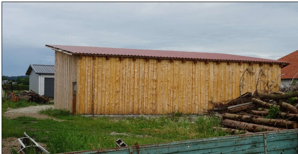
Abbildung 12: Neu errichtetes Nebengebäude in der Mitte des Flurstücks 2692 (e)
