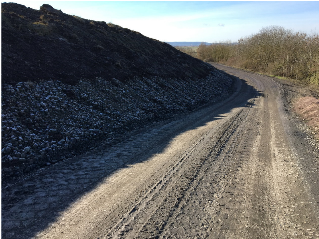
Böschung Q3 oberhalb Fahrweg am 04.02.19
