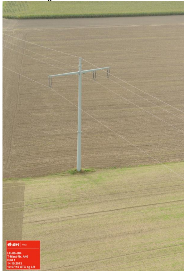
Foto 12: Ltg- Nr. J84 – Mast Nr. A40
