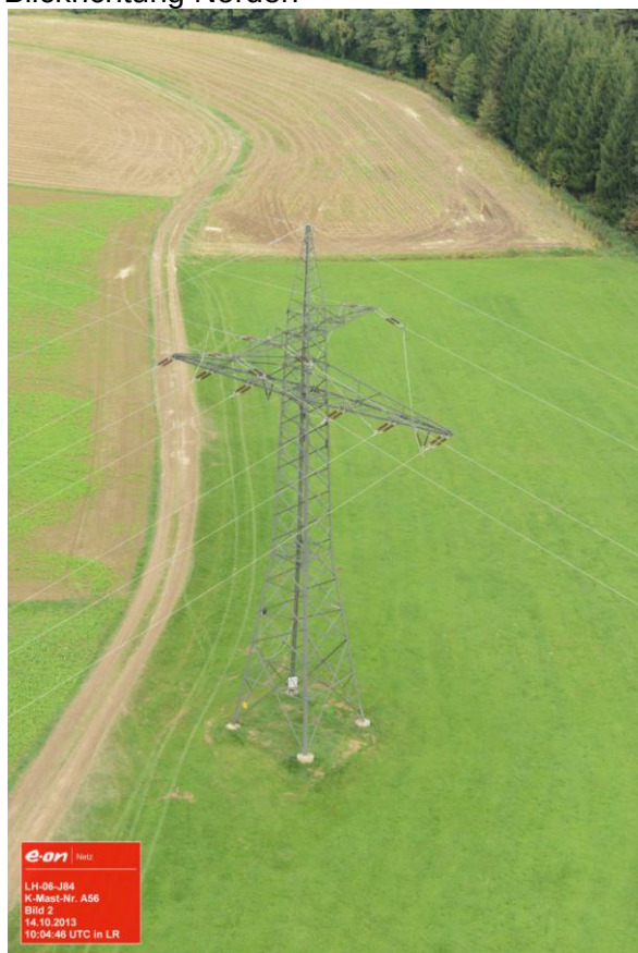
Foto 29: Ltg- Nr. J84 – Mast Nr. A56, Blickrichtung Norden
