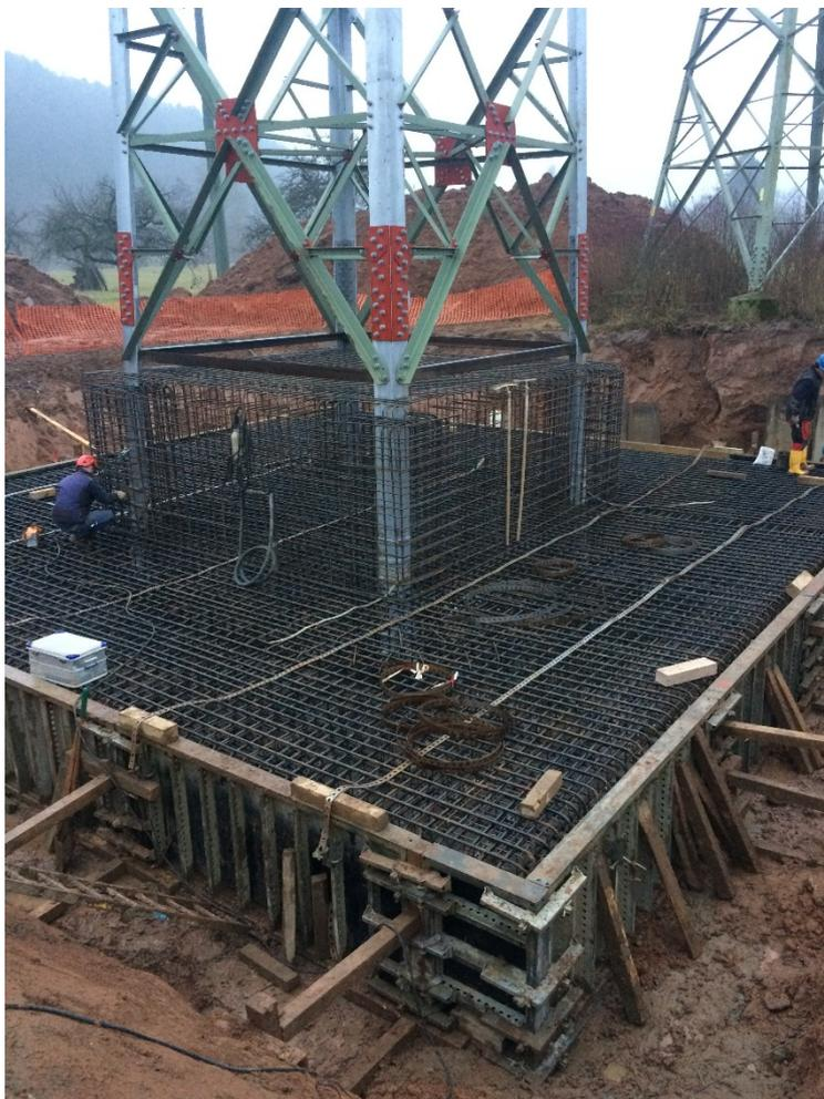
Abbildung 21: Beispiel für Fundamentarbeiten, Schalung und Bewehrungsstahl
