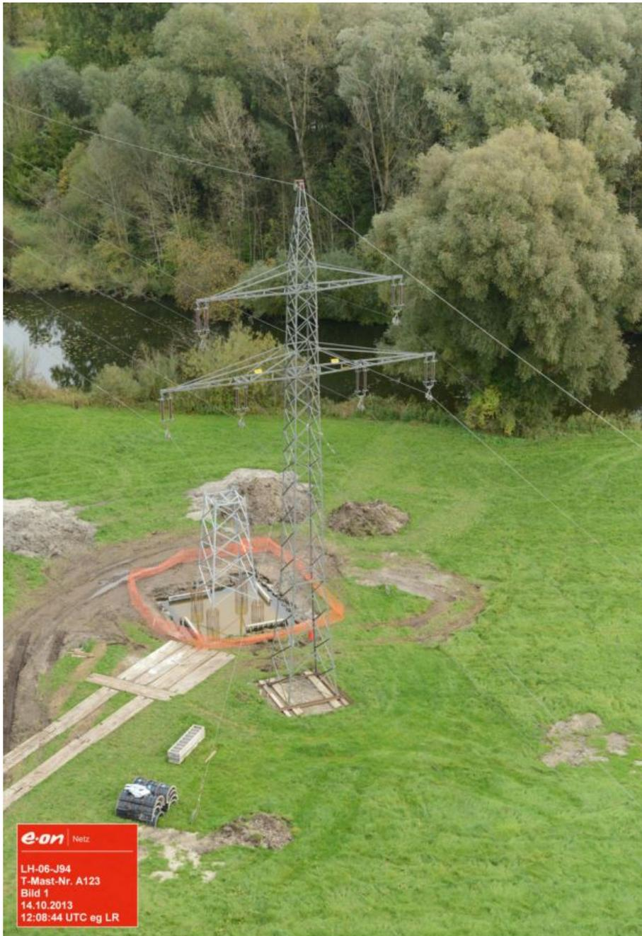
Abbildung 17: Arbeitsfläche 2013 für den Einbau eines neuen Unterteils des Masts A123 Ltg Nr. J94
