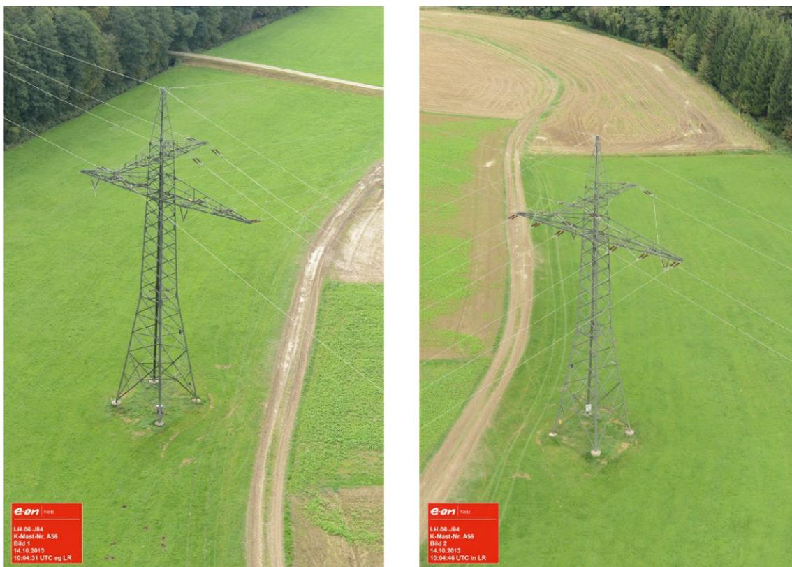
Abbildung 9: Stahlgittermast mit Donaumastbild (Kreuztraversenmast)
