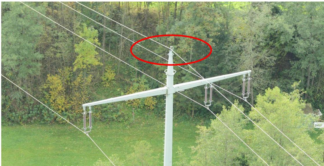
Abbildung 10: Blitzschutzseil an der Mastspitze
