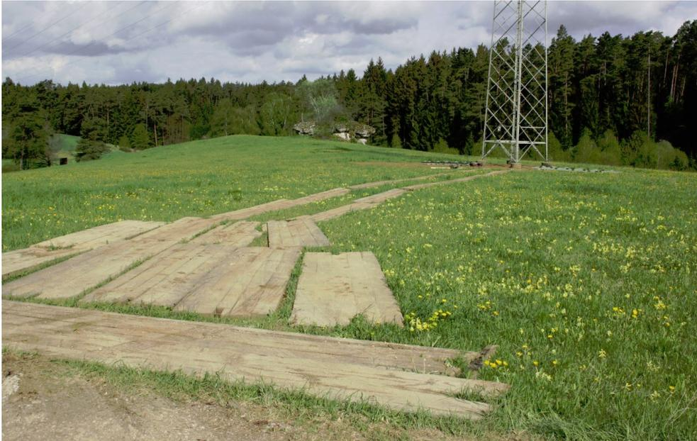
Abbildung 14: Zuwegung über Holzplatten (leichter Wegebau)
