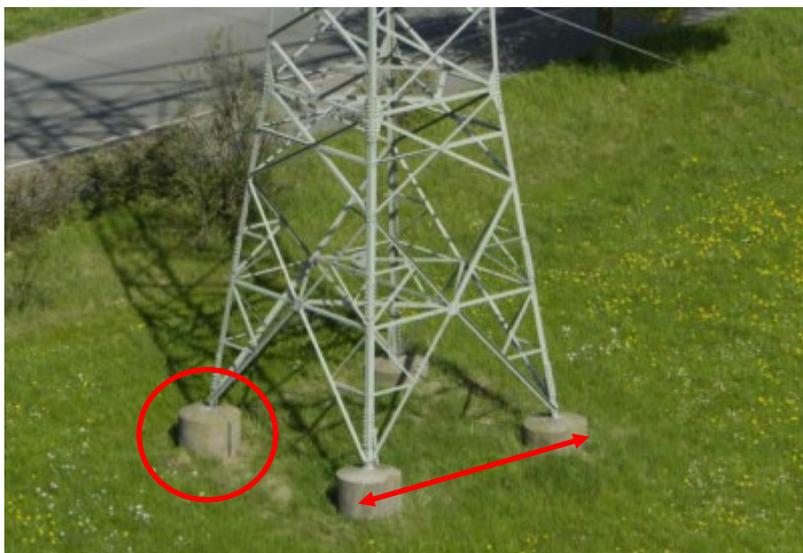
Abbildung 5: Sichtbare Betonfundamentköpfe und Bodenaustrittsmaß eines Stahlgittermastes
