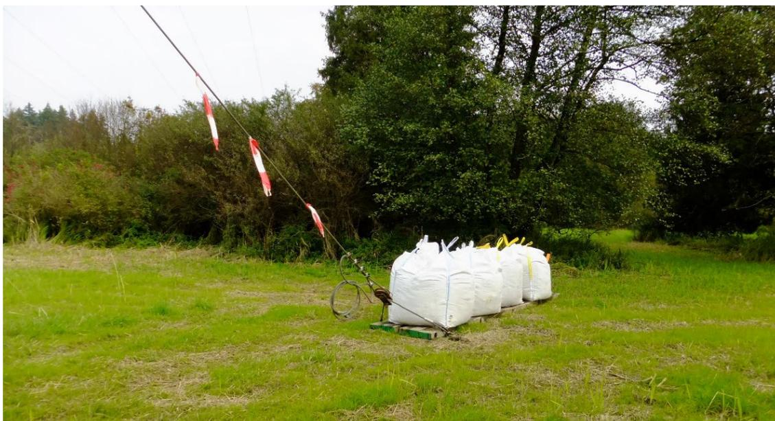
Abbildung 19: Abankerung mittels Ballastschlitten
