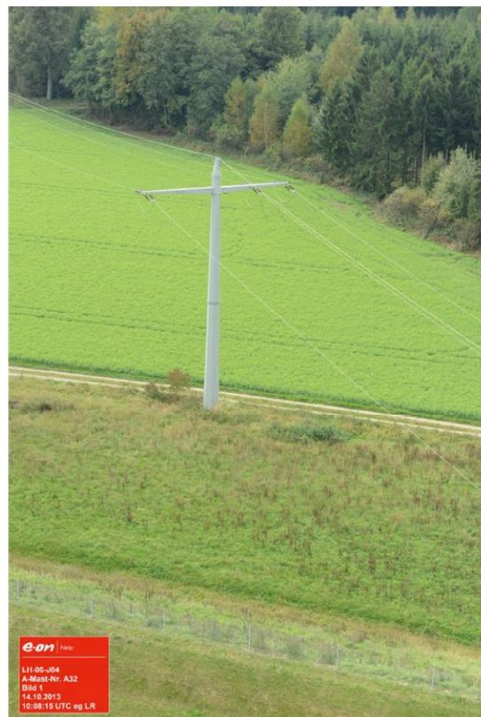
Abbildung 8: Stahlvollwandmasten mit Einebenenmastbild
