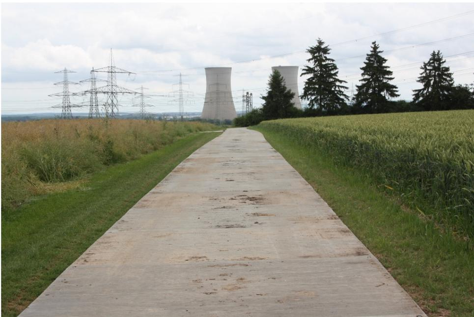
Abbildung 13: Zuwegung über Aluplatten (schwerer Wegebau)
