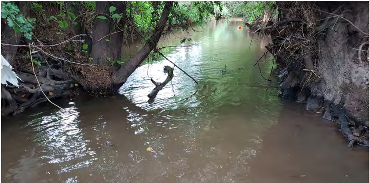
Abbildung 15: Unterspülte Uferbereiche mit Wurzelstrukturen, kleine Weisach A4, Quelle IBF-Umwelt
