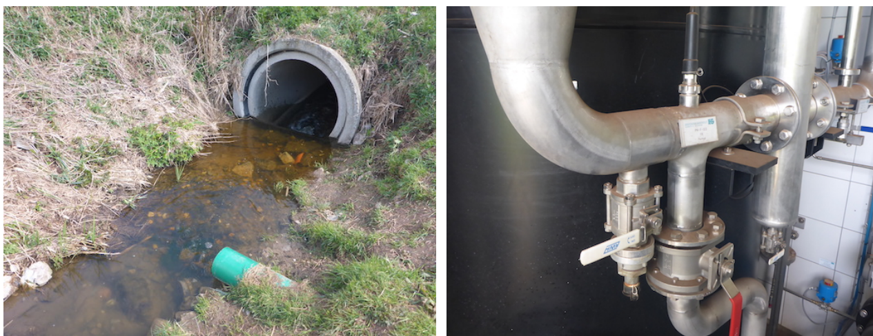
Abb. 3: Probestelle ARA am Sechselbach und im Anlagenhaus. Im Normalbetrieb fand die Probenentnahme üblicherweise im Freien am Auslauf des Abwasserrohres am Sechselbach statt (grünes Abwasserrohr im linken Bild), während bei den Versuchen zur Fällmittelreduktion und bei zu hohem Wasserstand im Sechselbach das Probenwasser im Anlagenhaus entnommen wurde (Hahn mit weißem Hebel im Vordergrund des rechten Bildes).
