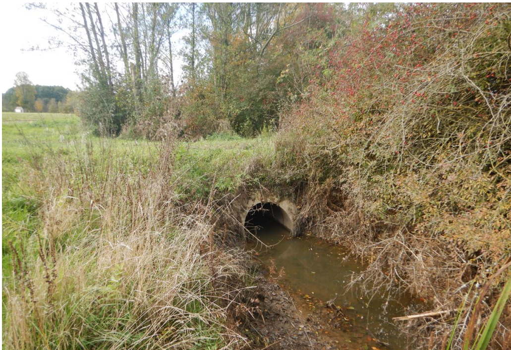
Abbildung 3.5: Durchlass DN1000 am Kühgaßbach
