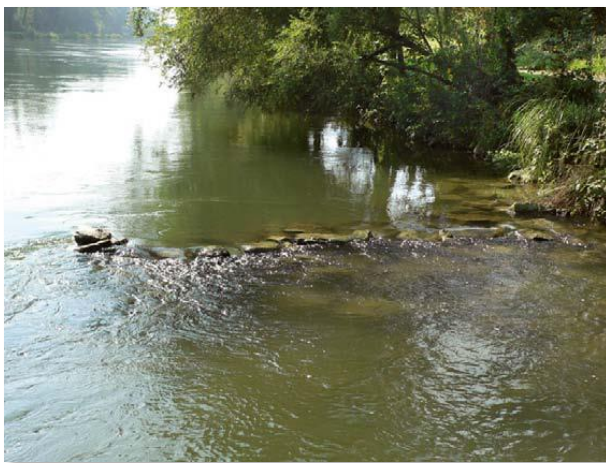
Abb. 30: Eine Leitbuhne sorgt für Strömungsvielfalt und bietet Unterstände (LFV Bayern 2010)
