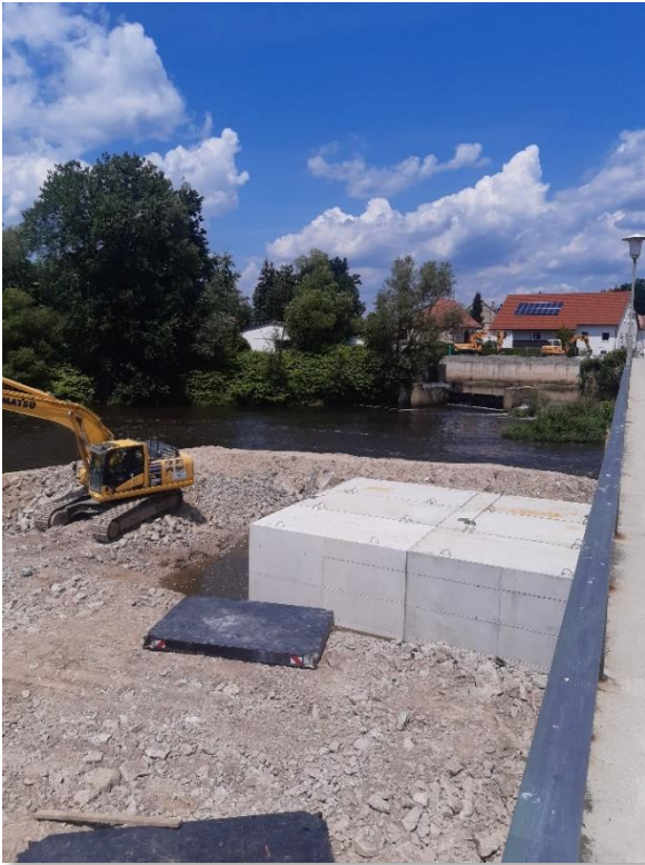
Abb. 29: Aufgeschüttete Baustraße am linken Pfeiler am 27.06.2020
