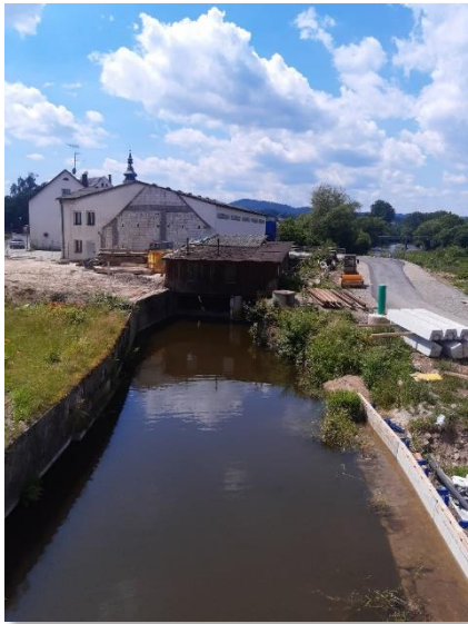
Abb. 12: Oberwasserkanal Hammermühle – Überlappungsbereich zwischen Brückenneubau und HWS Mauer
