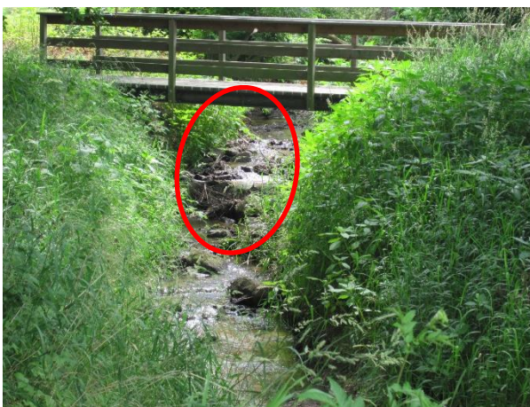
Abb. 35: Steinschüttung unter Brücke im Frühjahr
