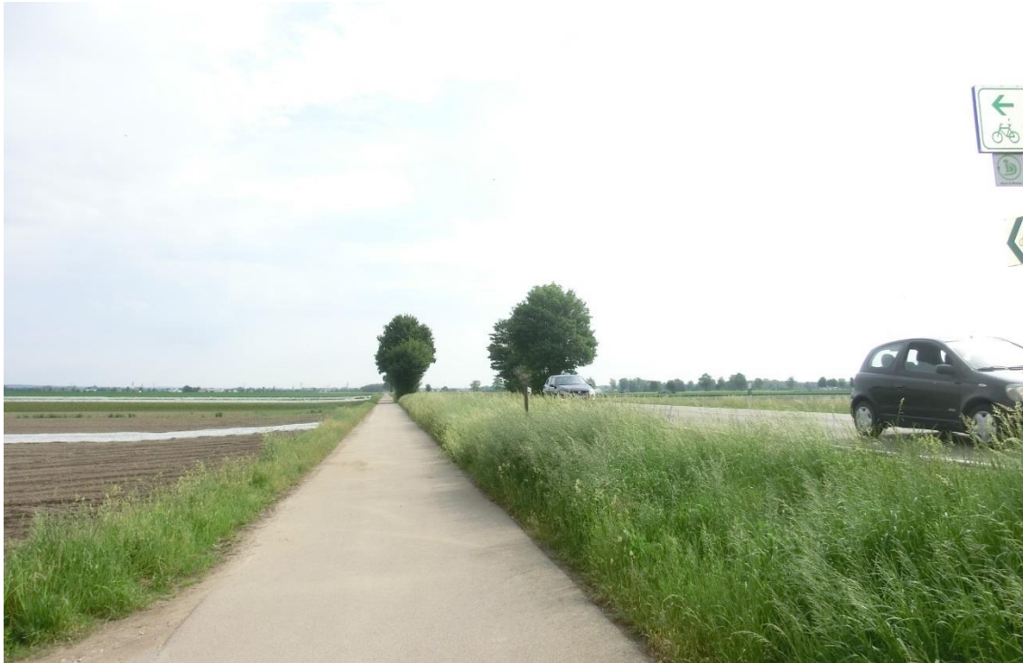
Abb. 9. Blick auf Radweg mit angrenzender B16
